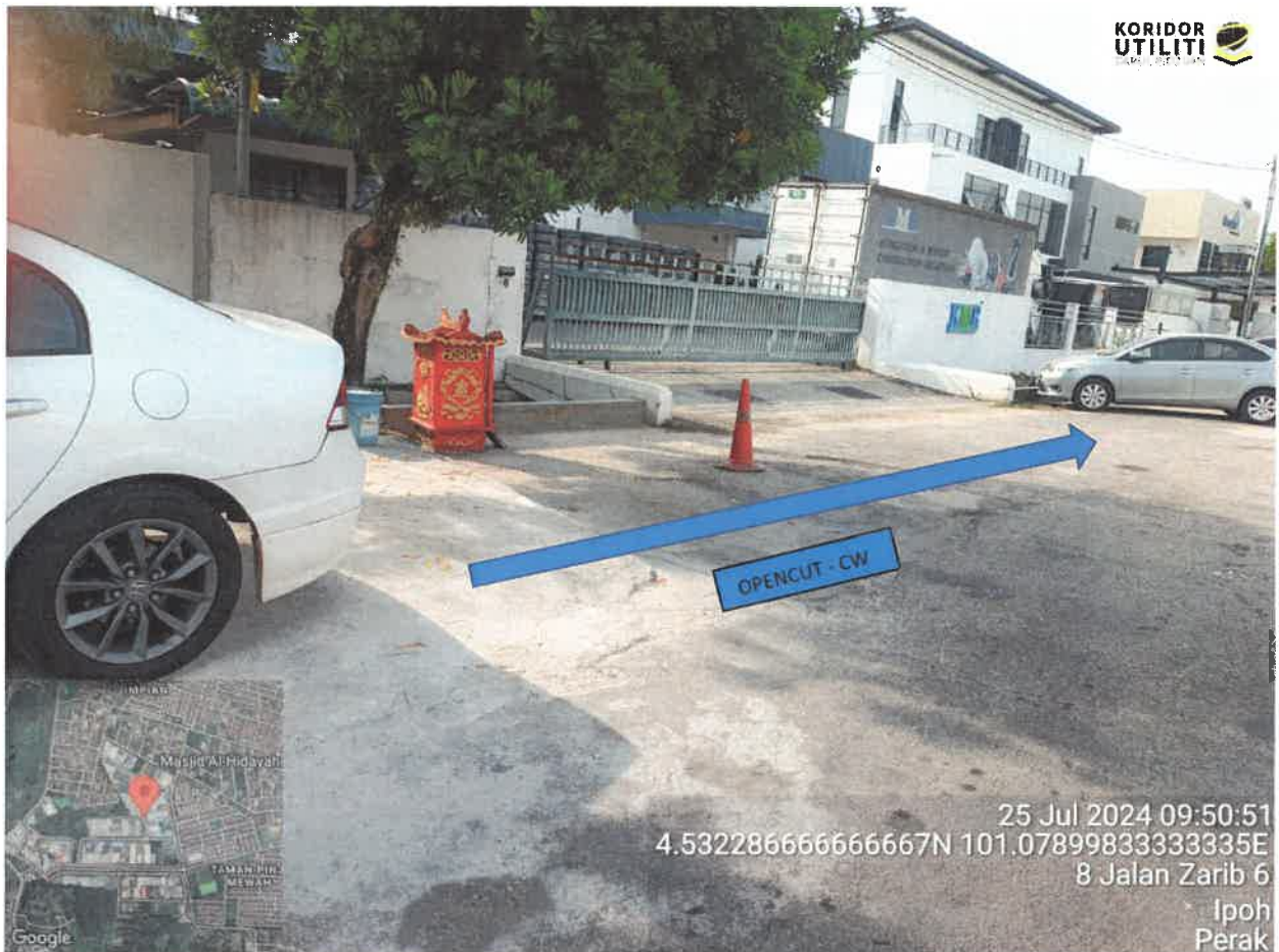
Kaedah OpenCut - CW - Jalan Zarib 6
