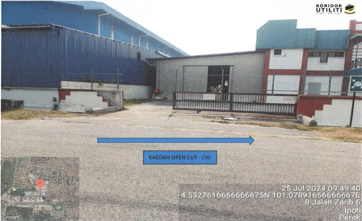
Kaedah OpenCut - CW - Jalan Zarib 6
