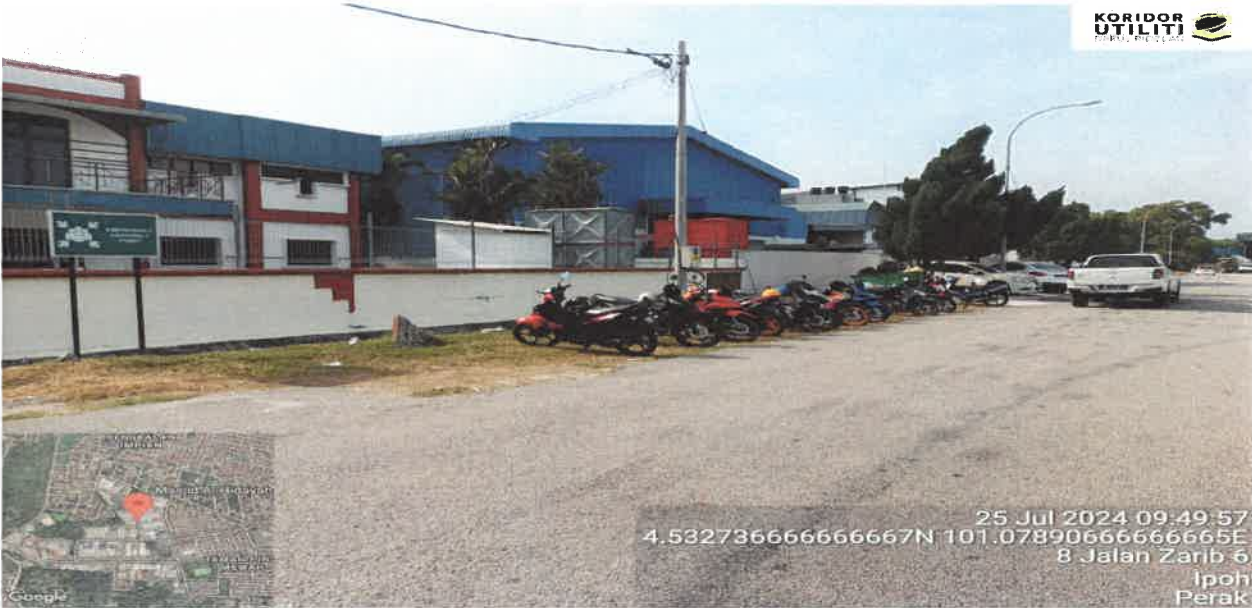
Kaedah OpenCut - Jalan Zarib 6
