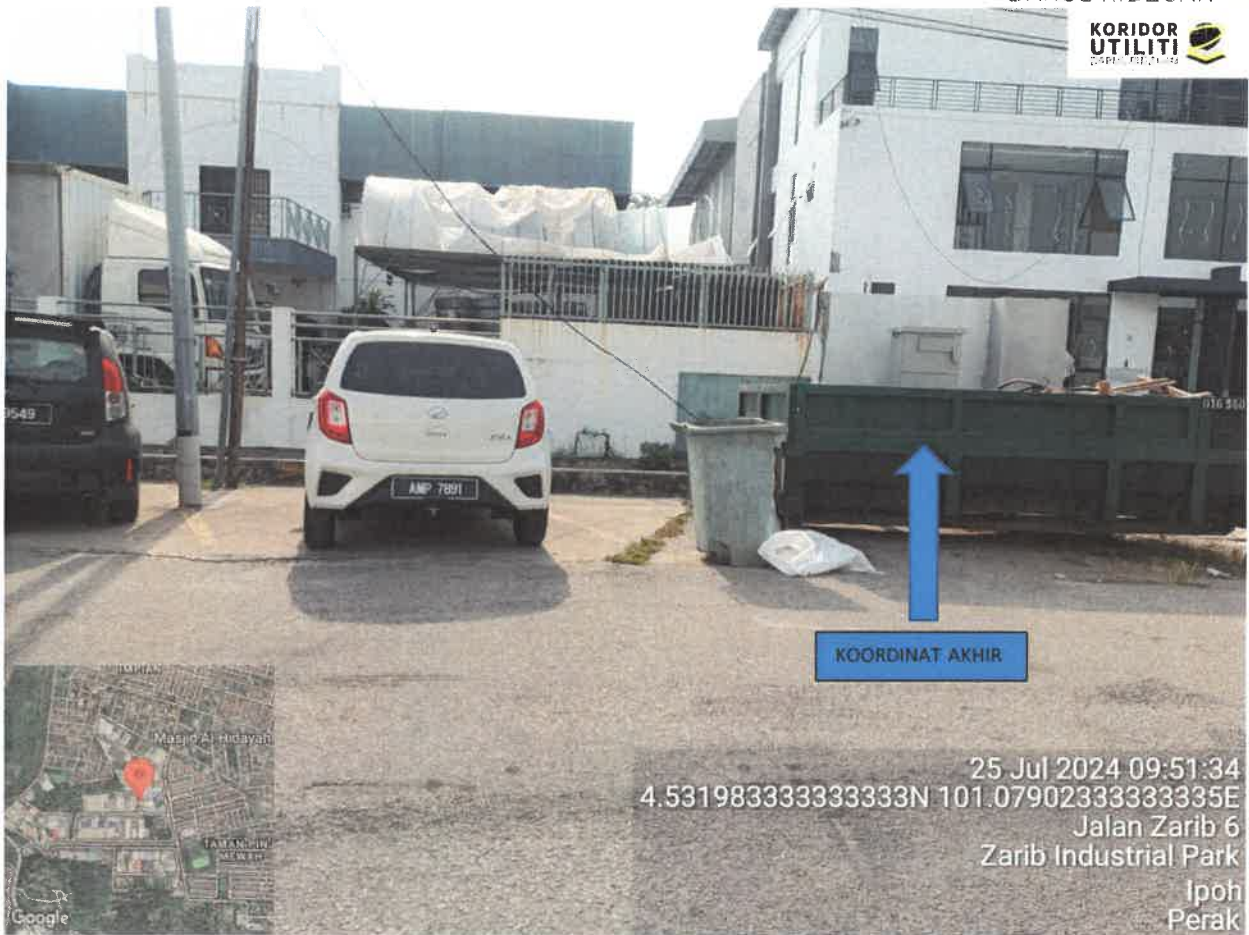
Koordinat akhir : 4.531935,101.079126 - TNB kiosk Meter - Jalan Zarib 6
