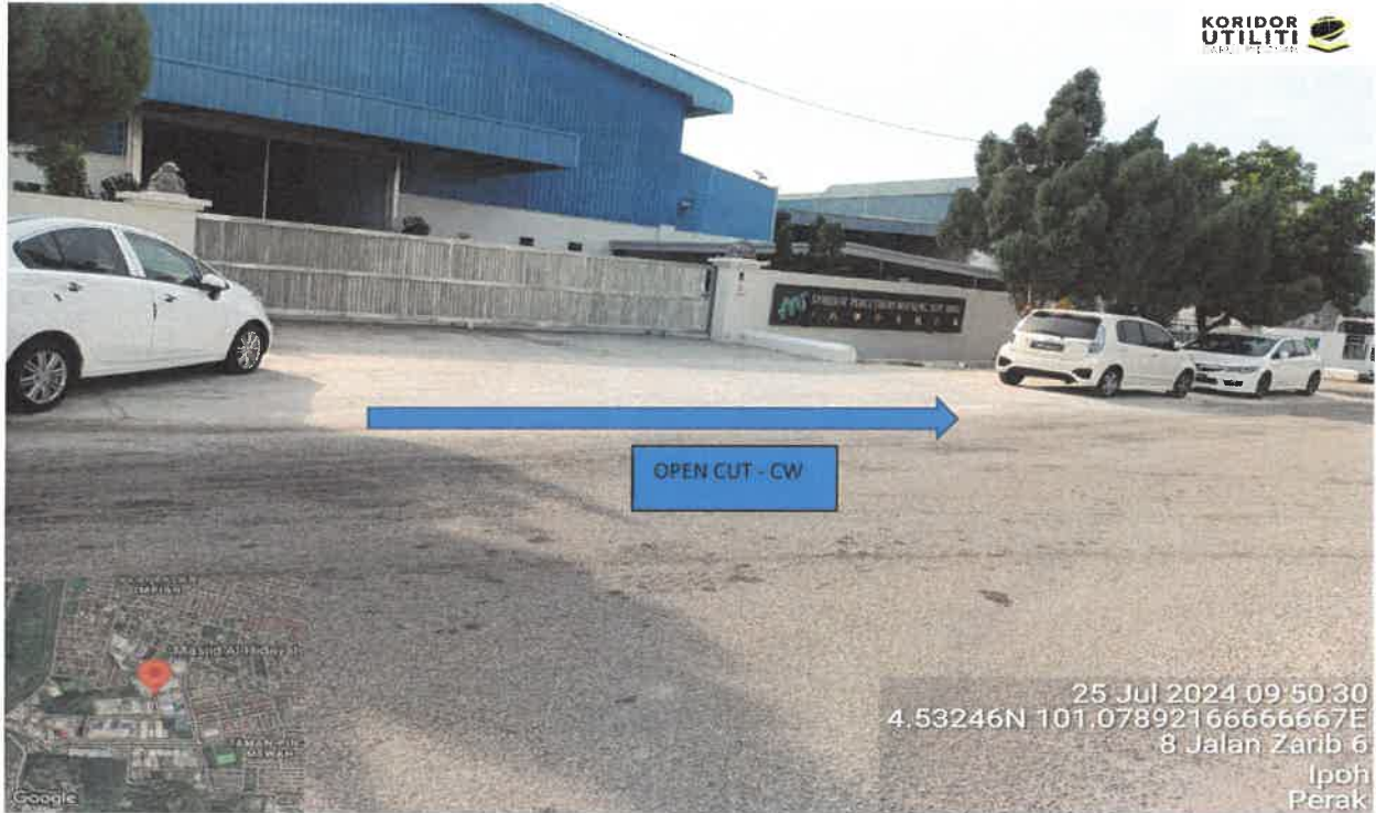
Kaedah OpenCut - CW - Jalan Zarib 6
