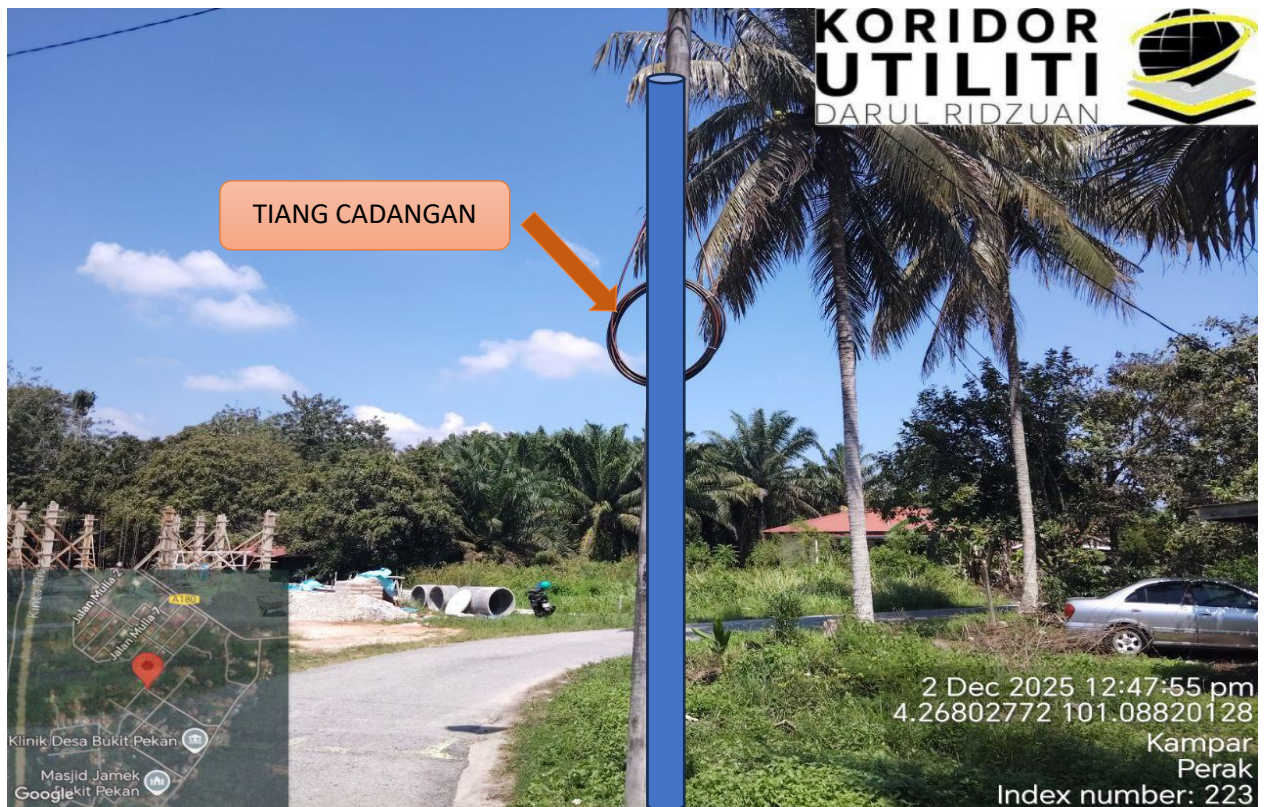
LOKASI JAJARAN PENANAMAN TIANG DI LORONG MANGGIS
