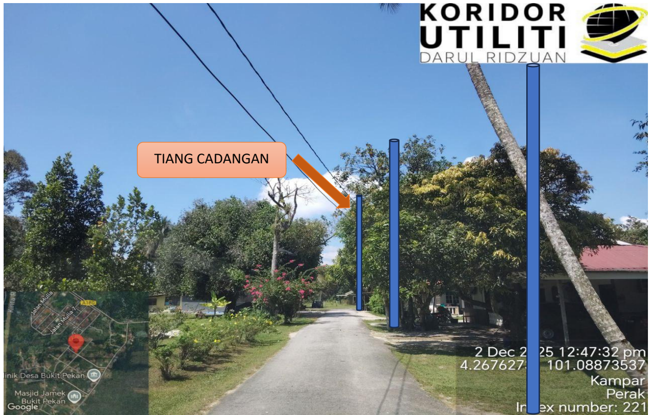
LOKASI JAJARAN PENANAMAN TIANG DI LORONG MANGGIS
