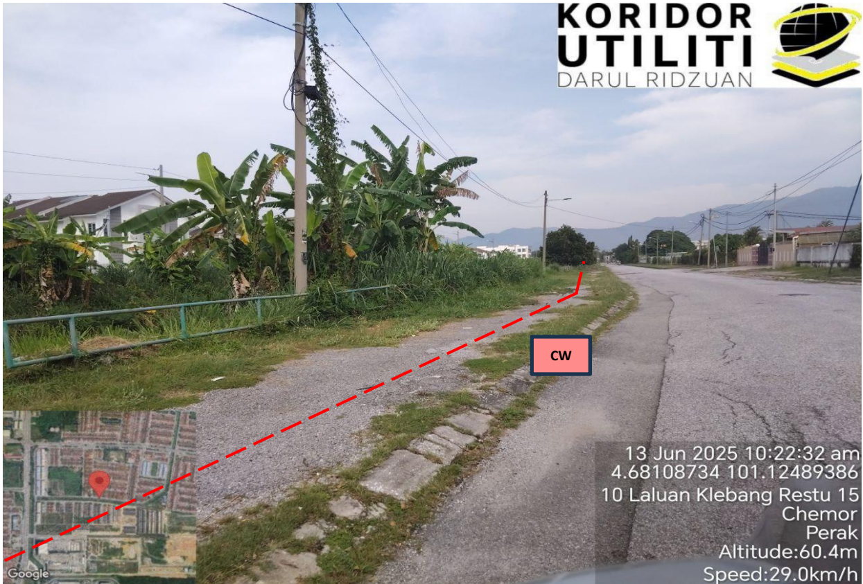
LOKASI KERJA KOREKAN TERBUKA DI LALUAN KLEBANG RESTU 15
