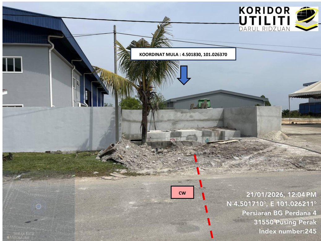
JAJARAN KOREKAN TERBUKA DI PERSIARAN BG PERDANA 4 (SAMBUNGAN KE CAD CSU 500KVA)
