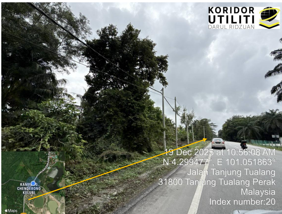
JAJARAN PEMASANGAN UTILITI
