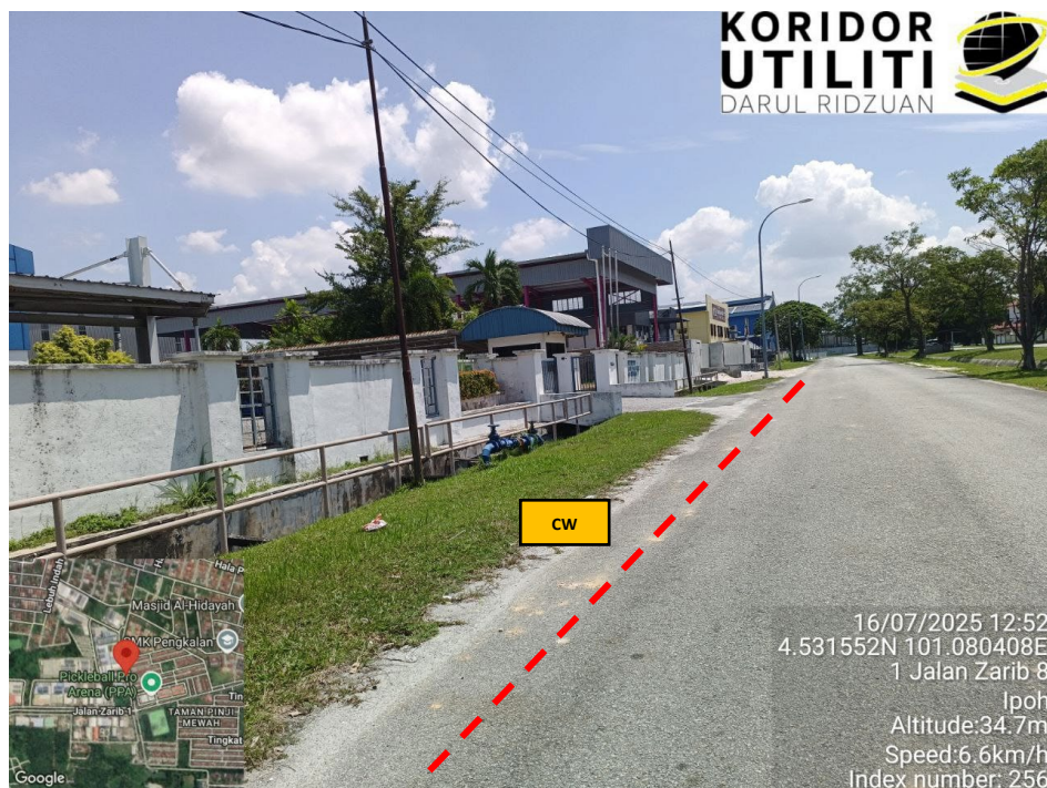
JAJARAN KOREKAN TERBUKA DI JALAN ZARIB 8
