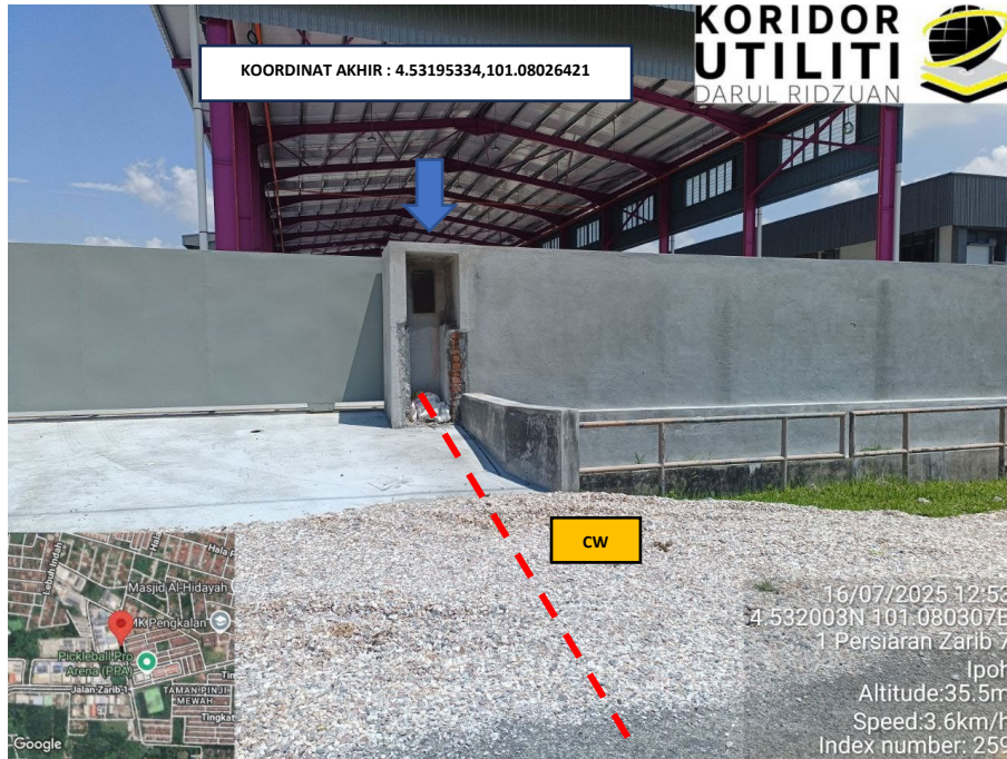
LOKASI KOORDINAT AKHIR KOREKAN TERBUKA DI JALAN ZARIB 8
