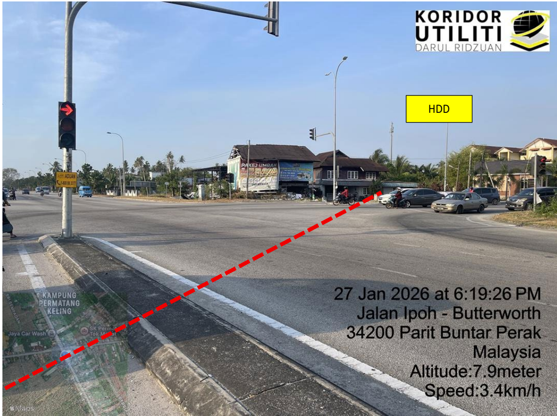
LOKASI DI JALAN IPOH - BUTTERWORTH
