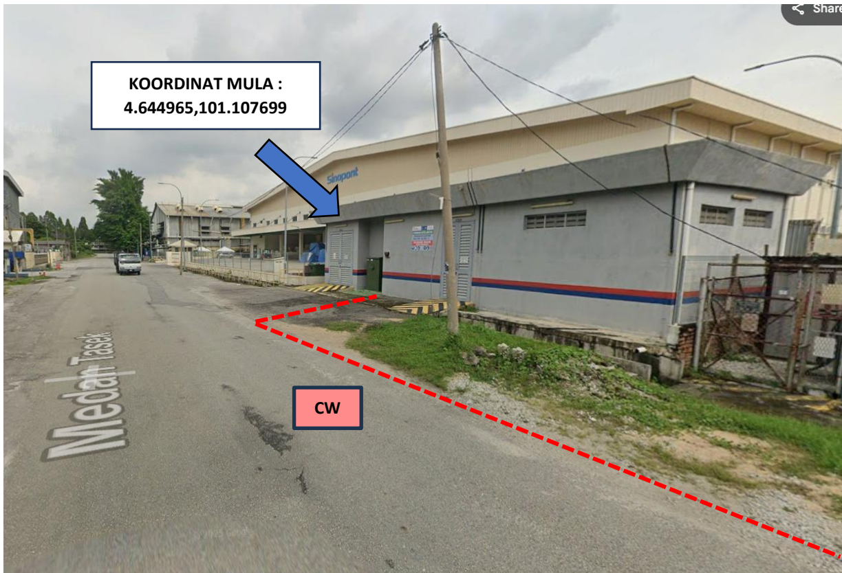
LOKASI KOORDINAT AKHIR KERJA KOREKAN TERBUKA DI MEDAN TASEK
