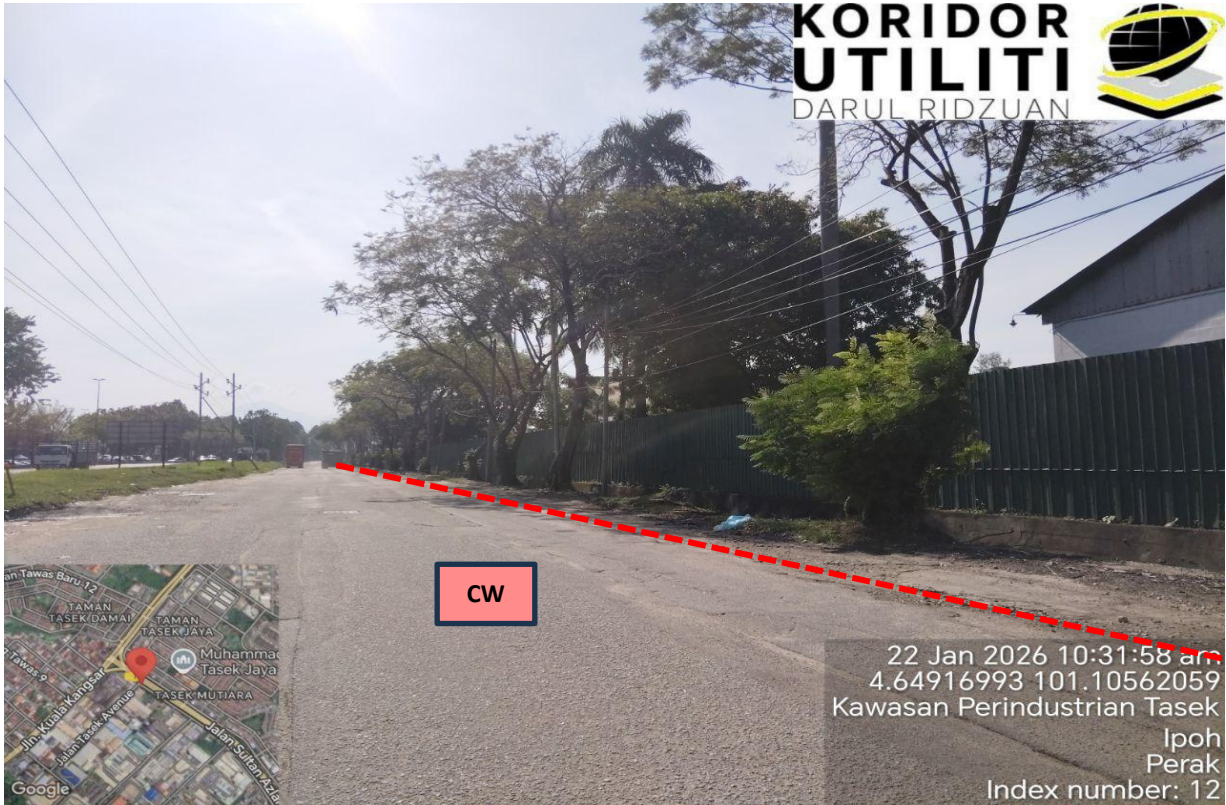
LOKASI KERJA KOREKAN TERBUKA DI PERSIARAN TASEK
