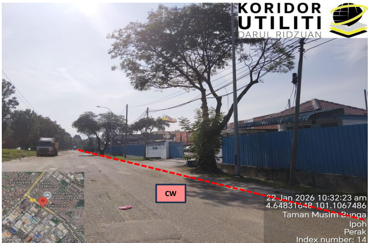
LOKASI KERJA KOREKAN TERBUKA DI PERSIARAN TASEK
