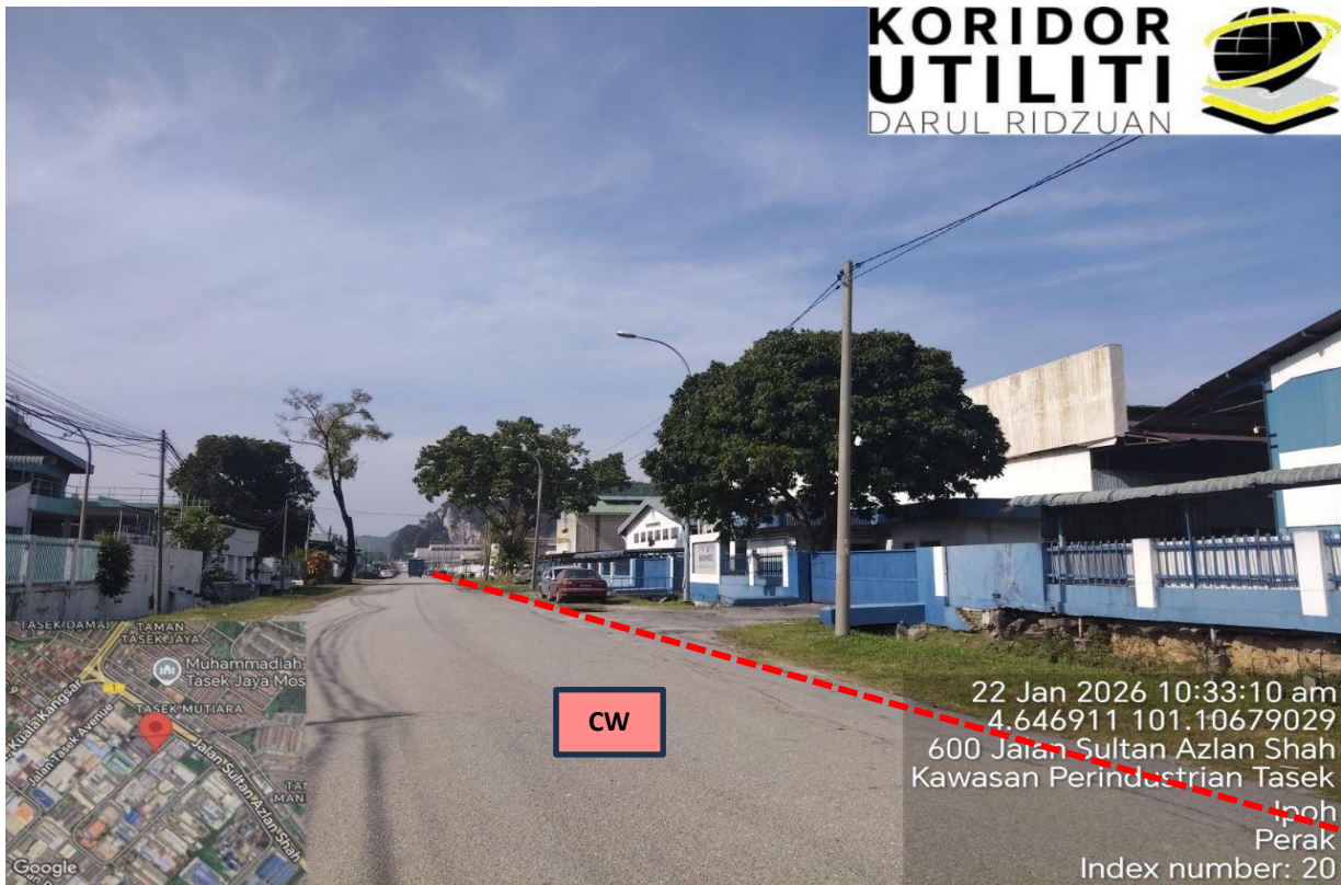
LOKASI KERJA KOREKAN TERBUKA DI MEDAN TASEK
