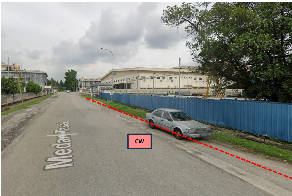
LOKASI KERJA KOREKAN TERBUKA DI MEDAN TASEK
