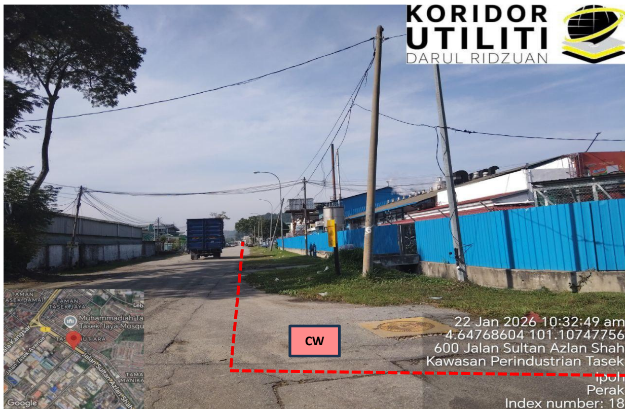
LOKASI KERJA KOREKAN TERBUKA DI MEDAN TASEK
