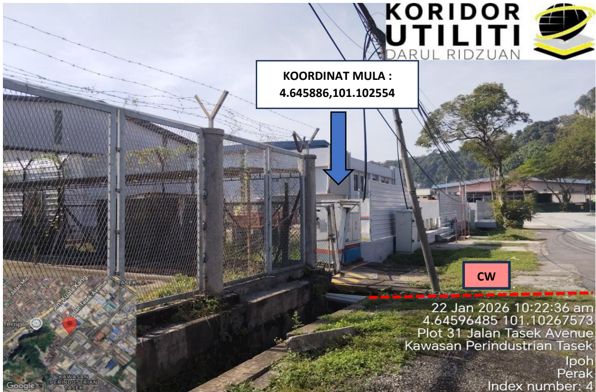
LOKASI KOORDINAT MULA KERJA KOREKAN HDD DI JALAN TASEK AVENUE
