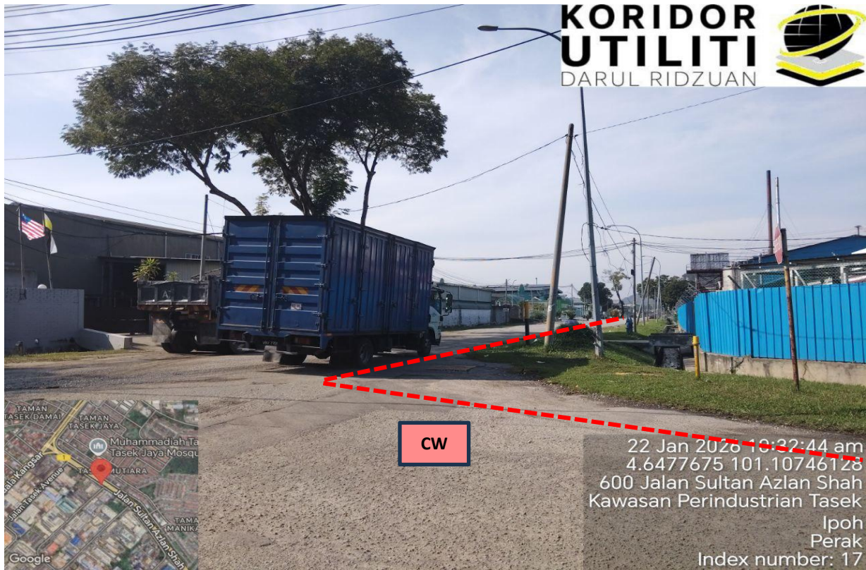
LOKASI KERJA KOREKAN TERBUKA DI PERSIARAN TASEK
