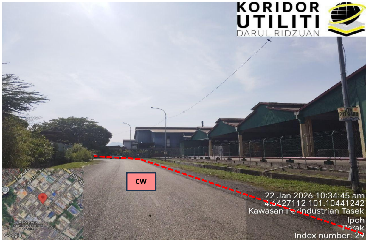
LOKASI KERJA KOREKAN TERBUKA DI MEDAN TASEK
