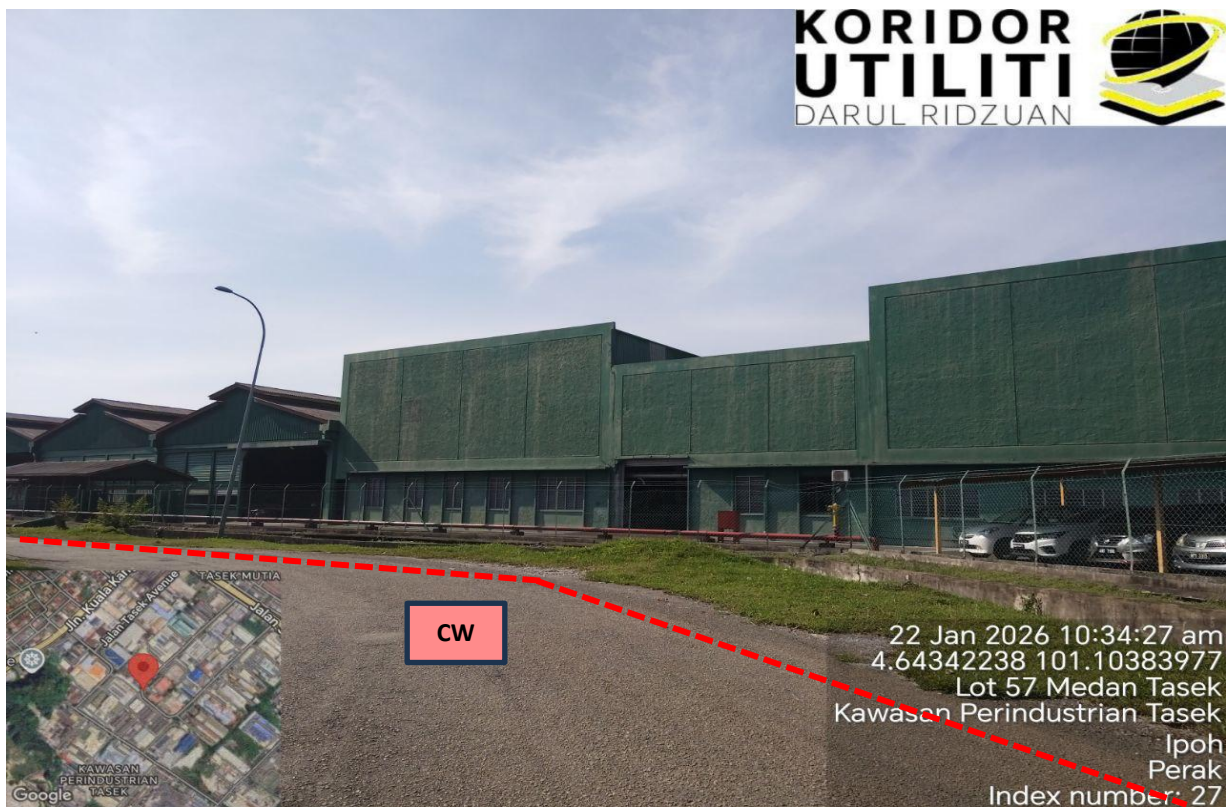
LOKASI KERJA KOREKAN TERBUKA DI MEDAN TASEK
