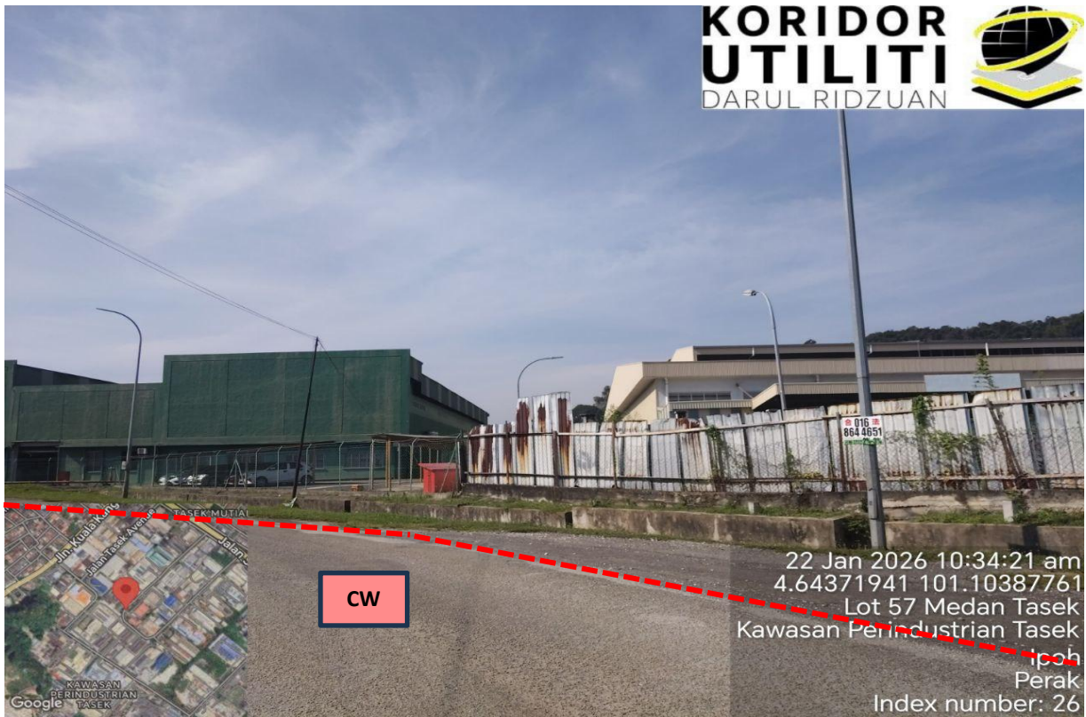
LOKASI KERJA KOREKAN TERBUKA DI MEDAN TASEK
