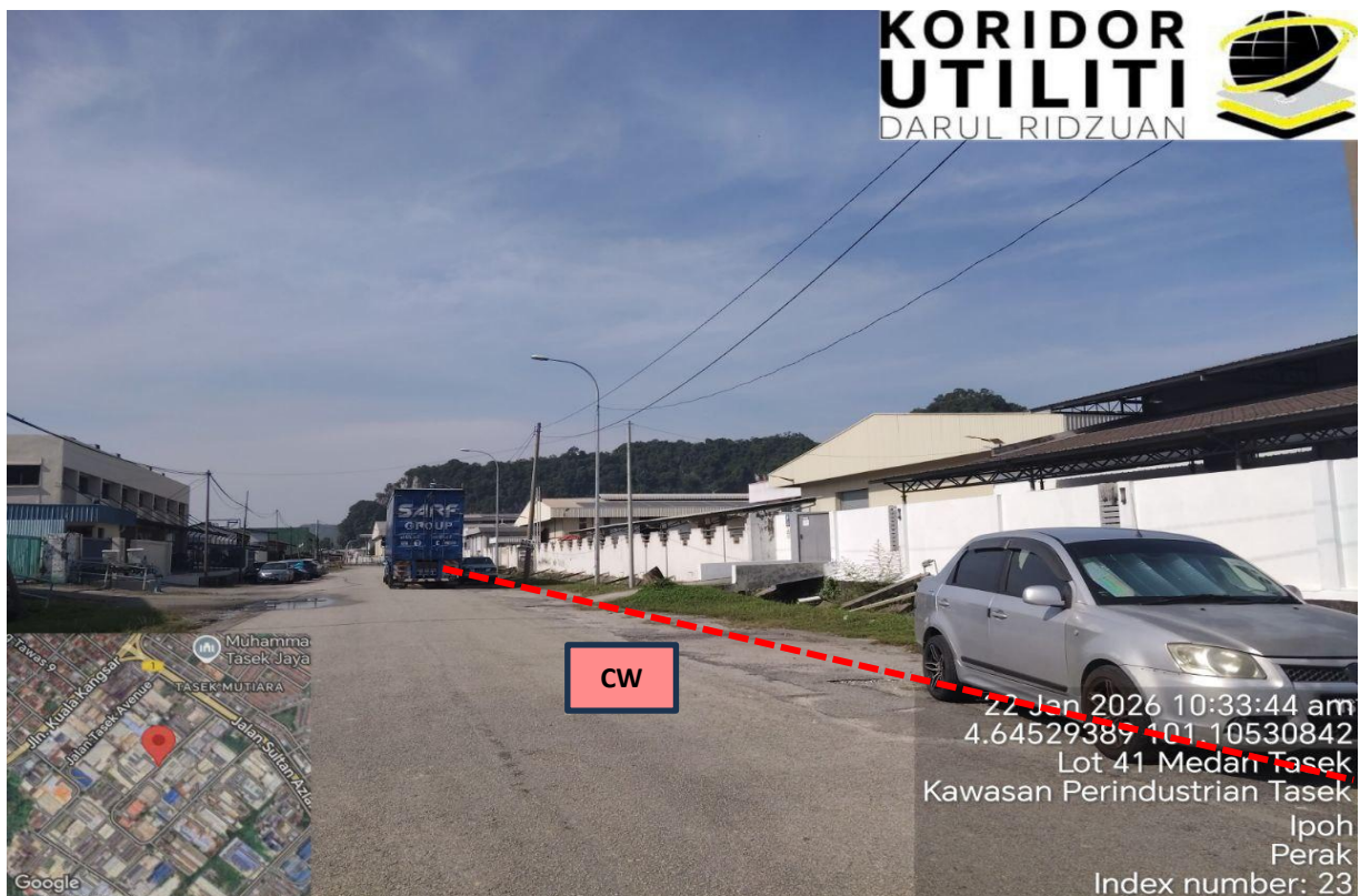
LOKASI KERJA KOREKAN TERBUKA DI MEDAN TASEK
