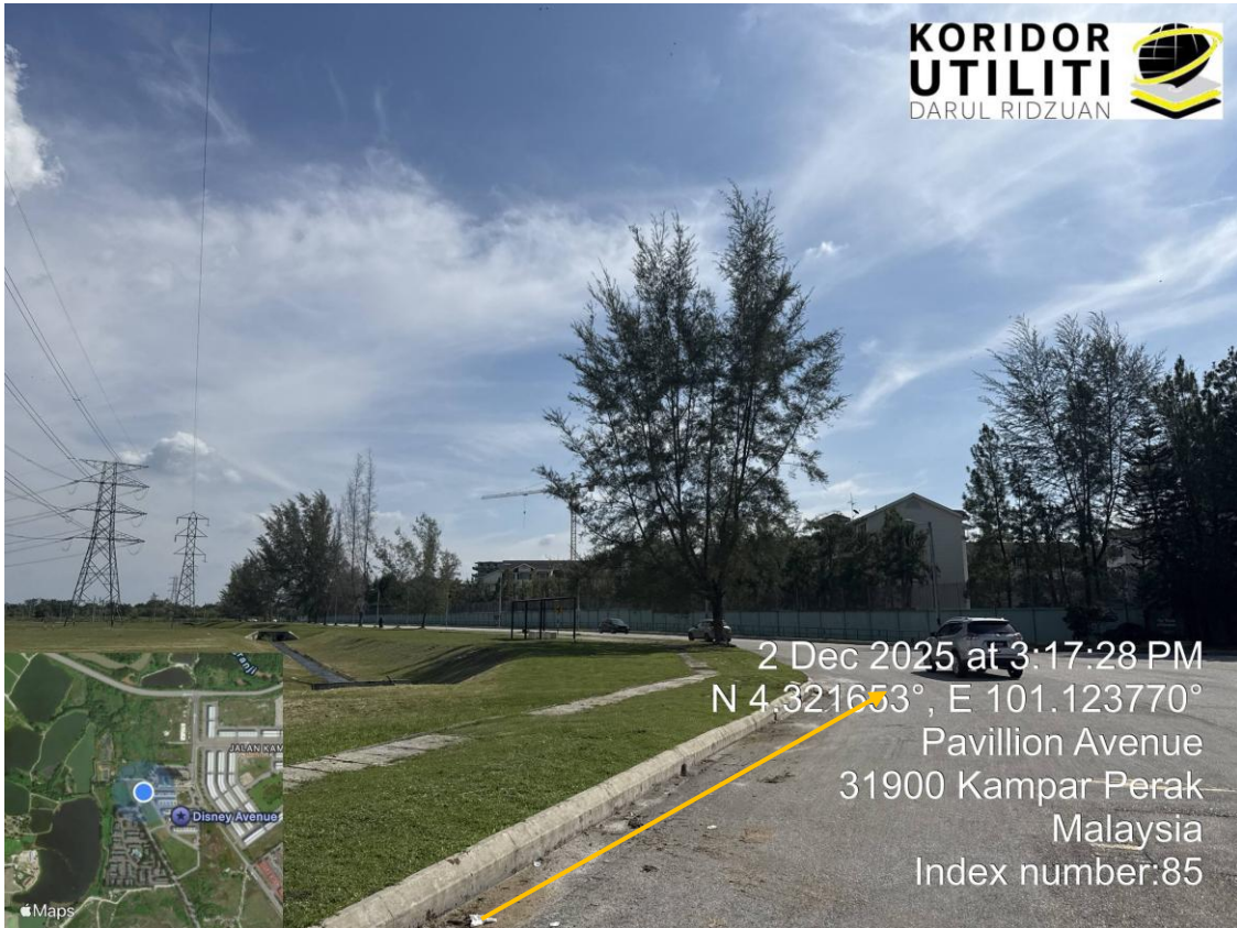
JAJARAN PEMASANGAN UTILITI
