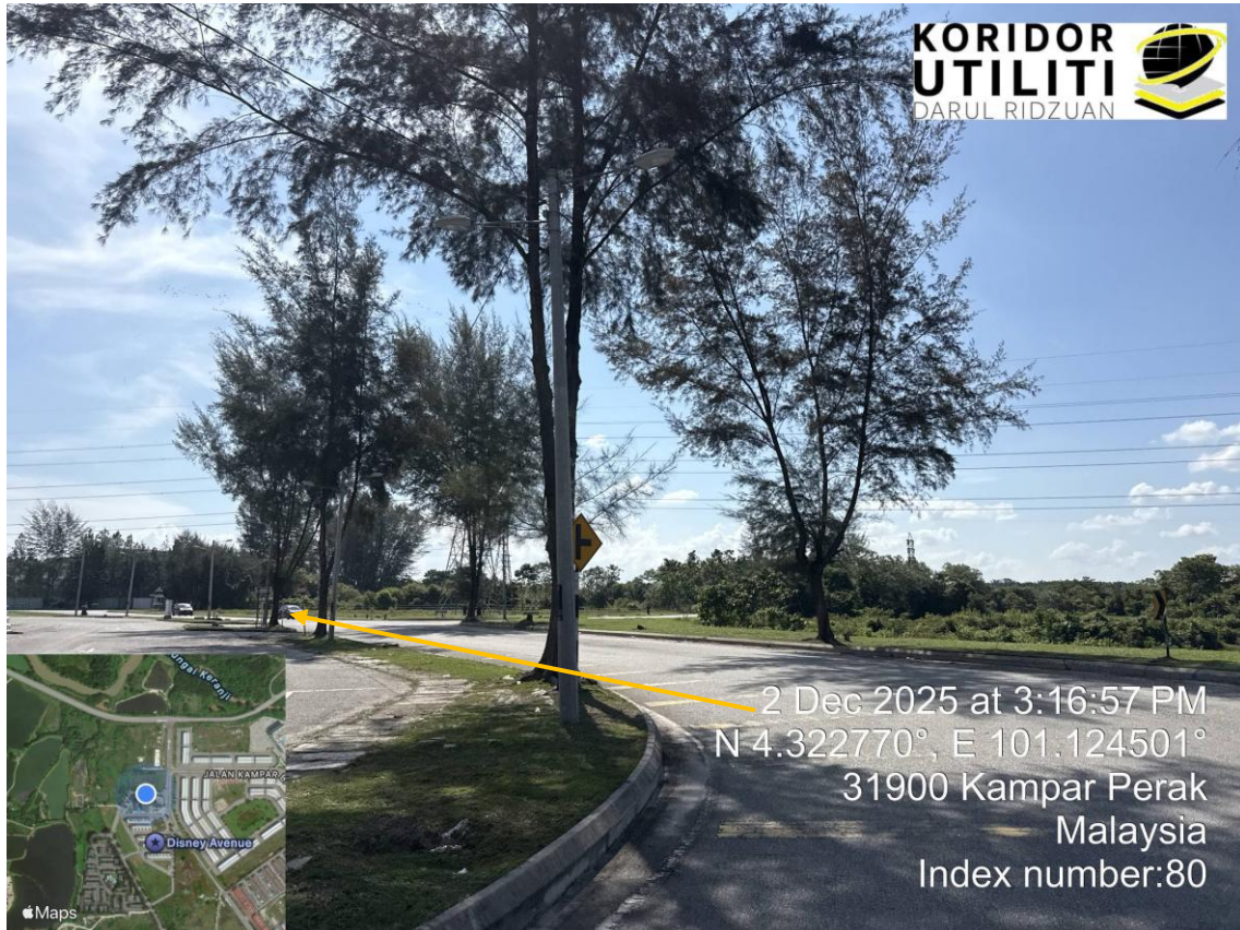
JAJARAN PEMASANGAN UTILITI
