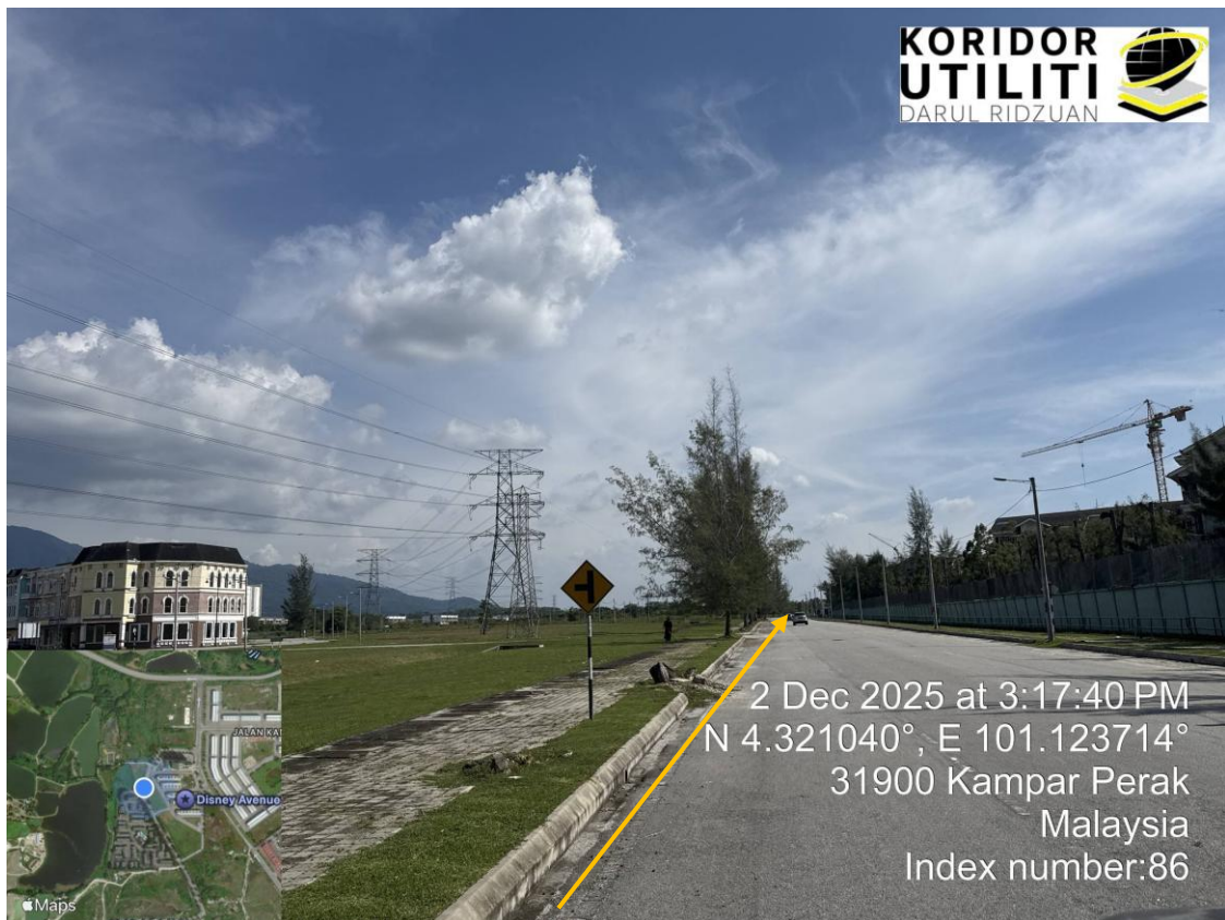
JAJARAN PEMASANGAN UTILITI
