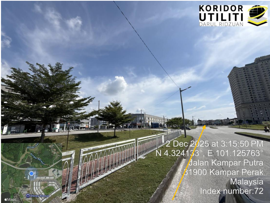
JAJARAN PEMASANGAN UTILITI
