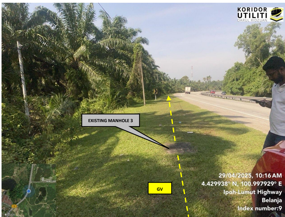
JAJARAN KOREKAN TERBUKA DI DI LEBUHRAYA IPOH – LUMUT (FT.05)
