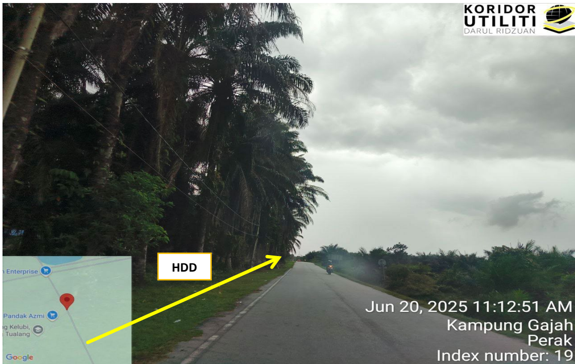
LOKASI : JALAN KG GAJAH – TANJUNG TUALANG (A015)
