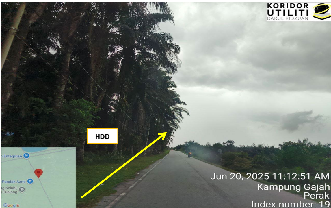
LOKASI : JALAN KG GAJAH – TANJUNG TUALANG (A015)
