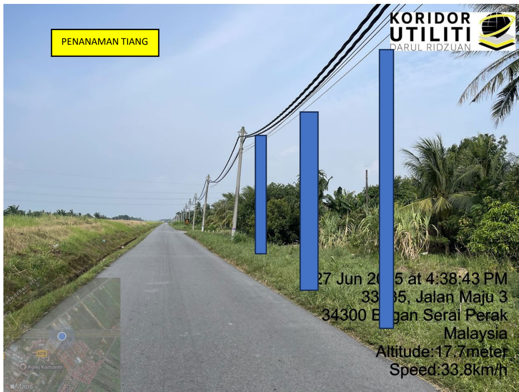
LOKASI DI JALAN TALI AIR KANAN
