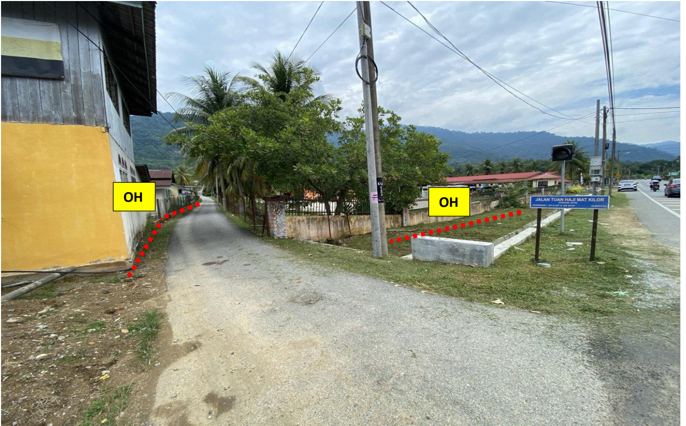
LOKASI DI PERSIMPANGAN MASUK KE JALAN TUAN HJ MAT KILOR
