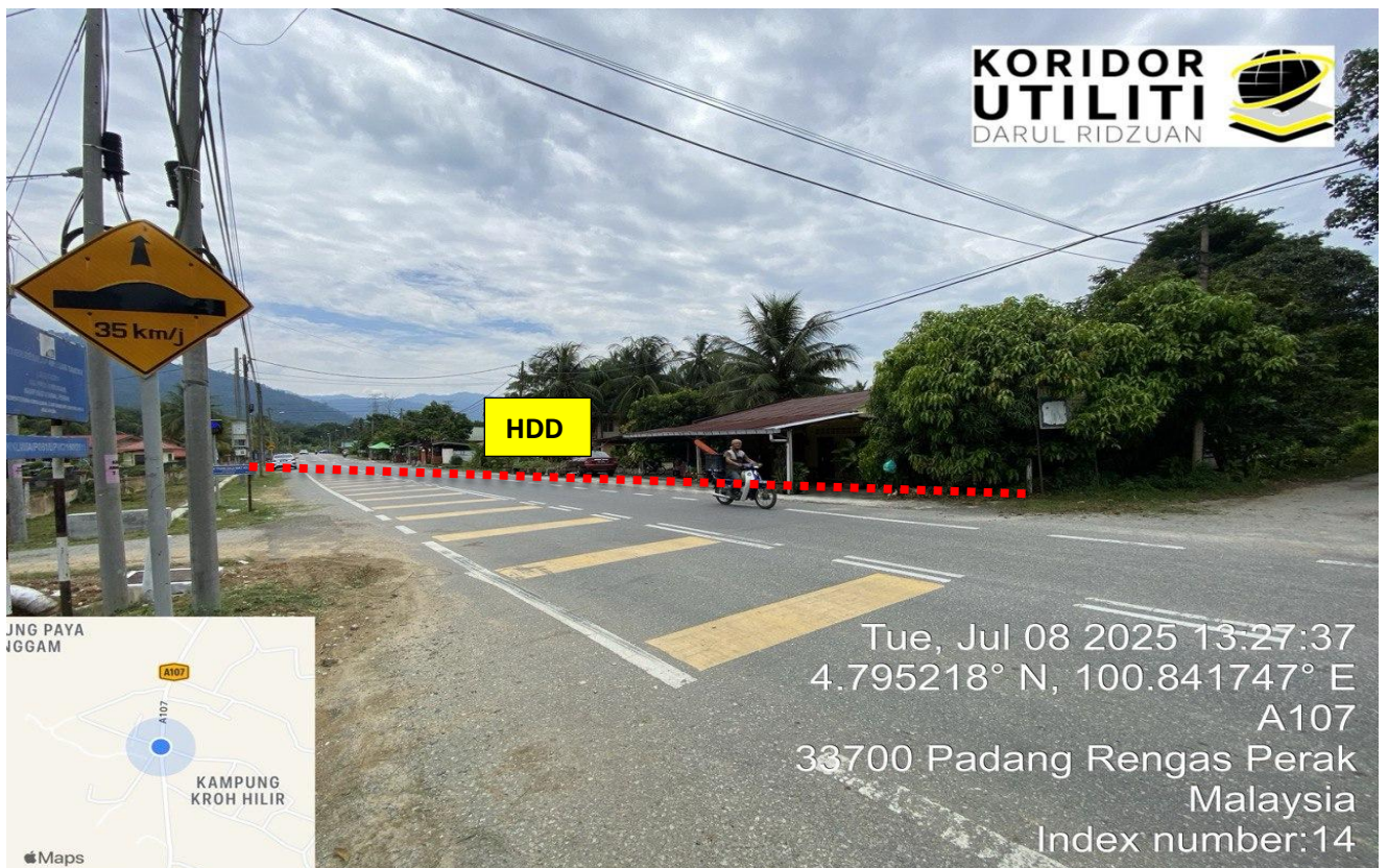
LOKASI DI JALAN PDG RENGAS-LUBUK MERBAU (A107)
