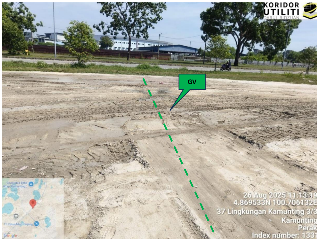
CADANGAN KOREKAN JALAN TIDAK BERTURAP (GV)
