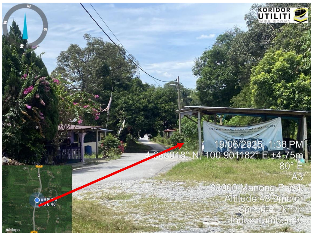
JALAN PDT – PENANAMAN TIANG MENGIKUT JAJARAN TIANG TNB SEDIA ADA
