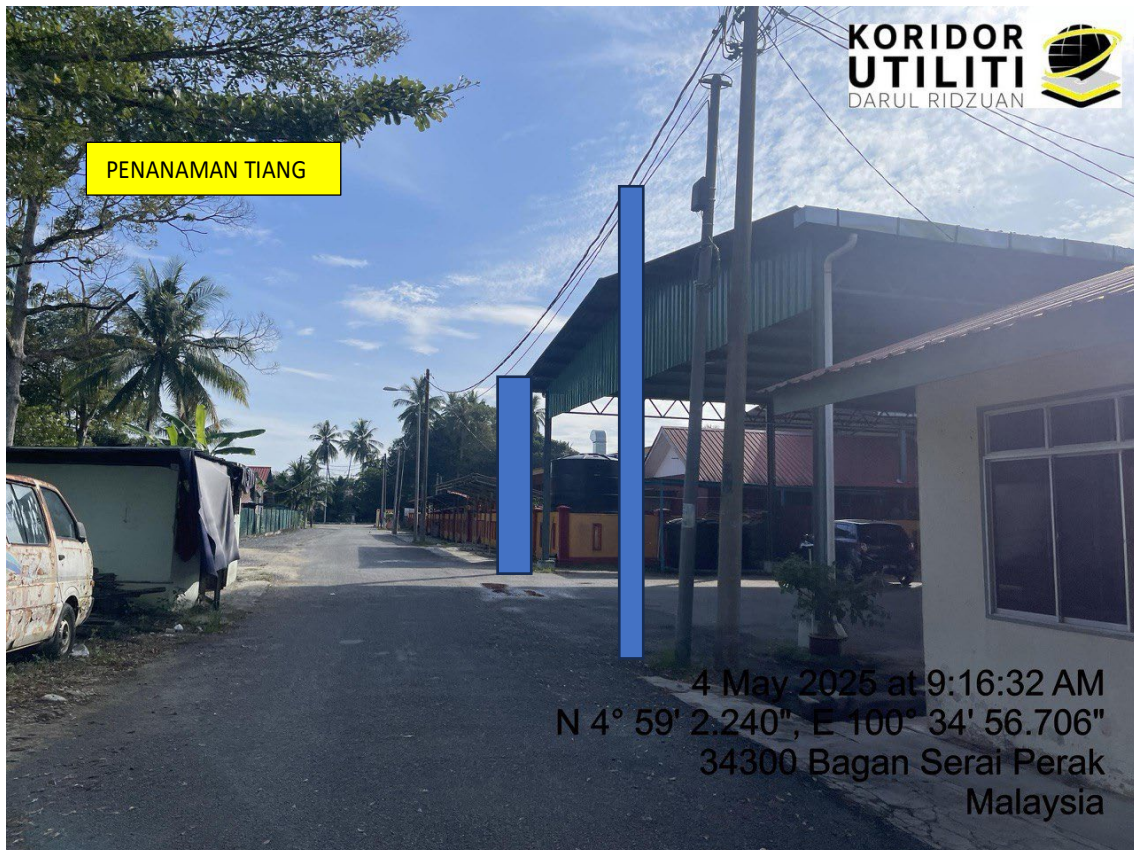
LOKASI DI JALAN KAMPUNG PARIT HAJI TAHIR
