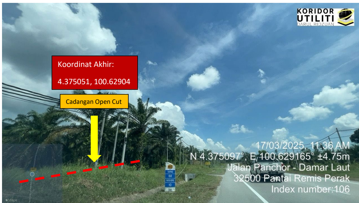
Gambar 13: Koordinat Akhir untuk Kerja-kerja pengorekan menggunakan kaedah Grass Verge Way Open Cut Trenching (GV)
