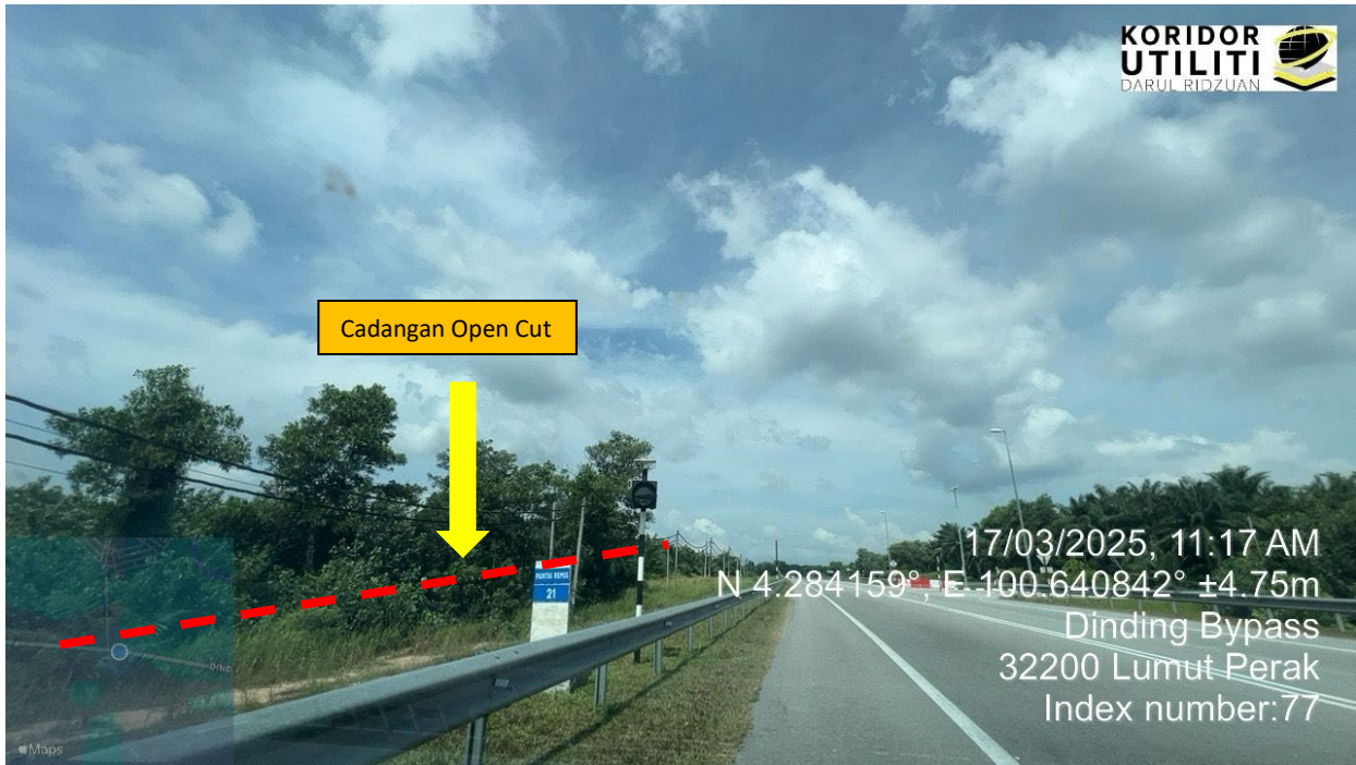
Gambar 5: Jalan Changkat Jering Sri Manjung Kampung Koh – Kerja-kerja pengorekan menggunakan kaedah Grass Verge Way Open Cut Trenching (GV)
