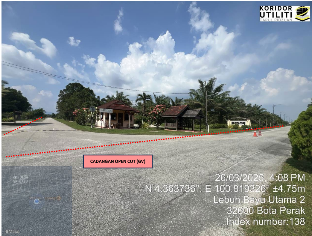
LOKASI KERJA: LEBUH BAYU UTAMA 1 KE ARAH LEBUH BAYU UTAMA 2
