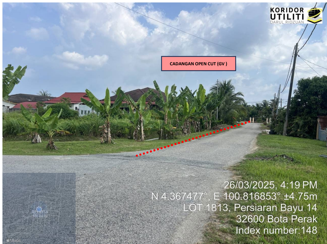
LOKASI KERJA: PERSIARAN BAYU 14 KE ARAH LEBUH BAYU UTAMA 3
