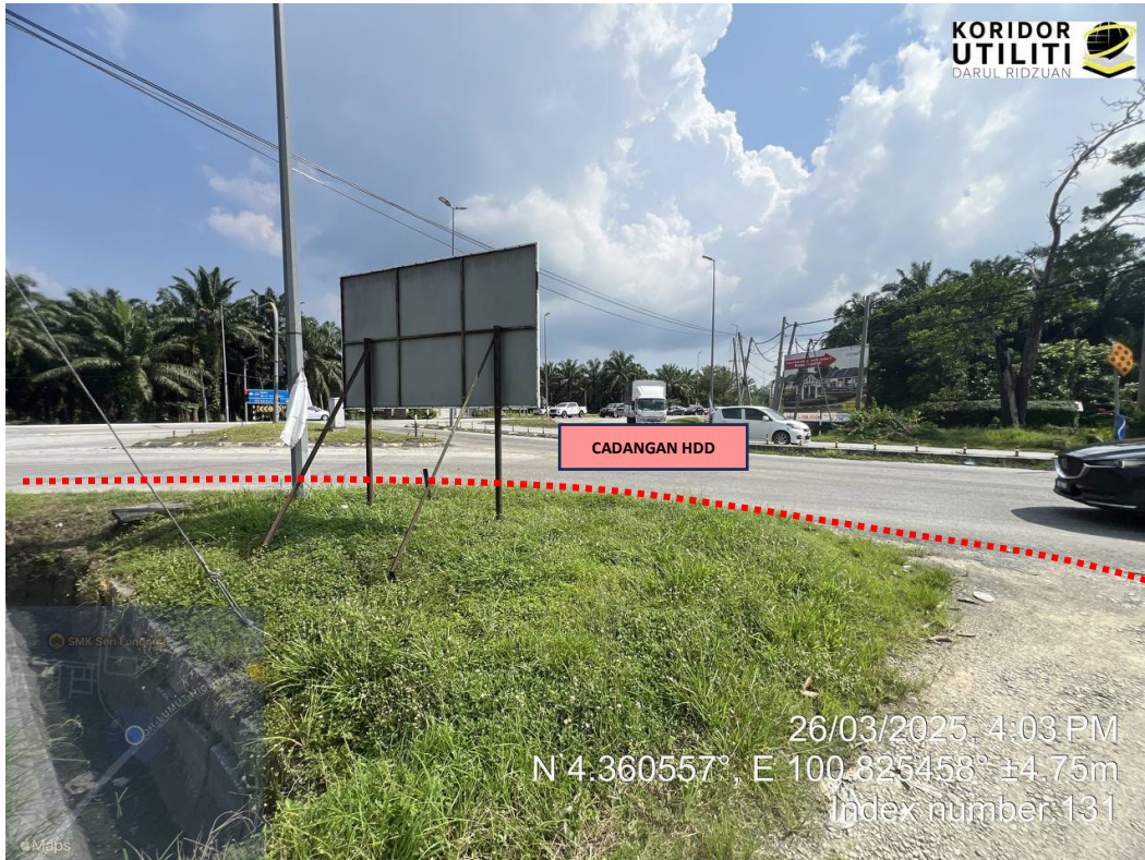
LOKASI KERJA: LEBUHRAYA IPOH – LUMUT KE ARAH JALAN GELUNG PEPUYU
