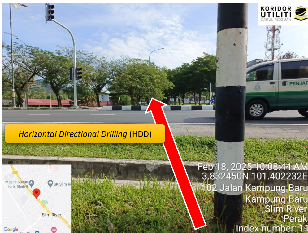
LOKASI DI LALUAN PERSEKUTUAN 1, KOREKAN HORIZONTAL DIRECTIONAL DRILLING (HDD), KAWASAN JKR
