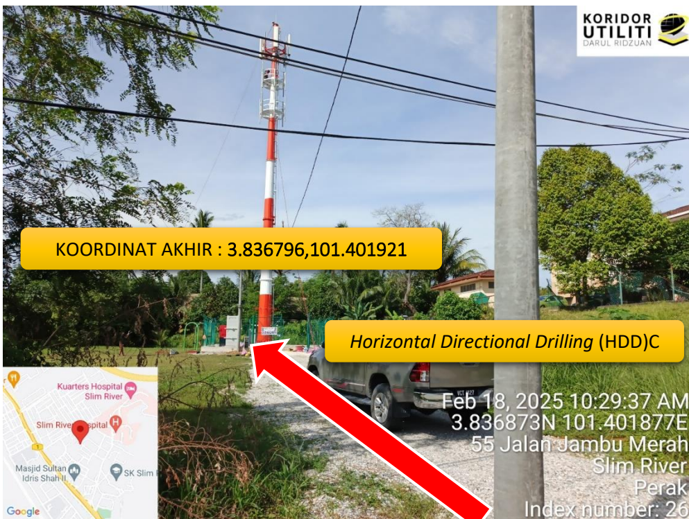
LOKASI DI JALAN JAMBU MERAH, KOREKAN HORIZONTAL DIRECTIONAL DRILLING (HDD), DISAHKAN SEBAGAI KAWASAN MDTM OLEH PIHAK MDTM
