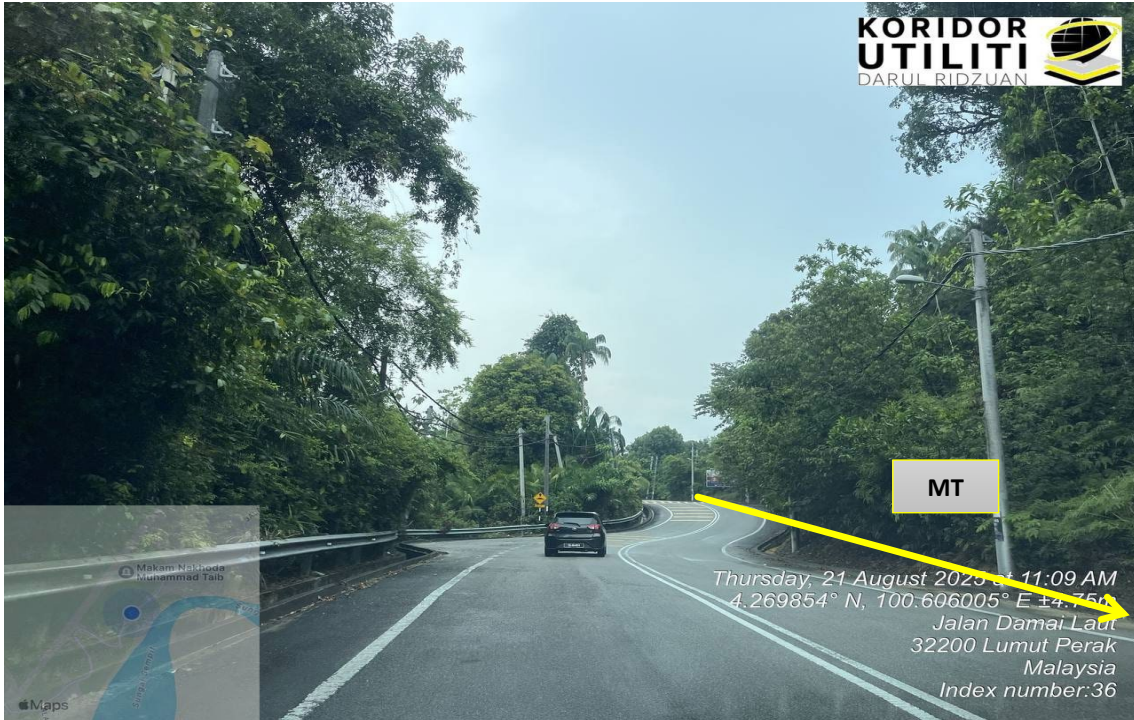
LOKASI KERJA DI JALAN DAMAI LAUT
