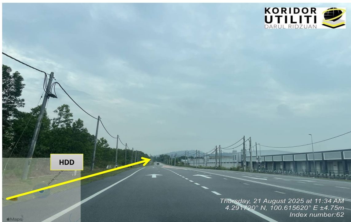
LOKASI KERJA DI JALAN TELUK SENANGIN (A241)
