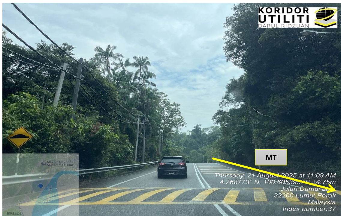
LOKASI KERJA DI JALAN DAMAI LAUT
