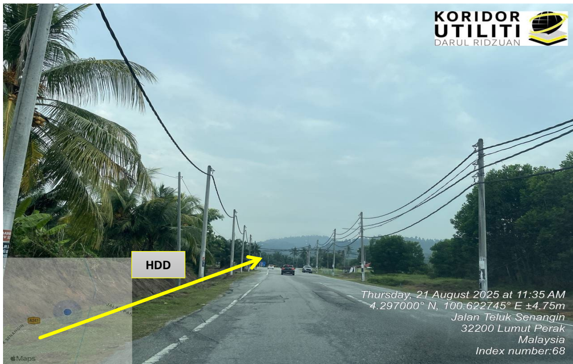
LOKASI KERJA DI JALAN TELUK SENANGIN (A241)
