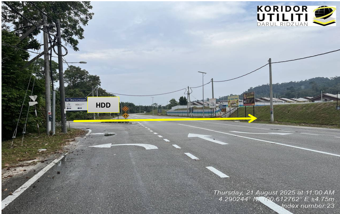
LOKASI KERJA DI JALAN TELUK SENANGIN (A241)
