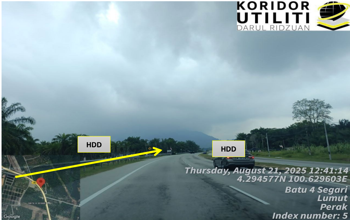
LOKASI KERJA DI JALAN CHANGKAT JERING-SRI MANJUNG-KAMPUNG KOH (60)
