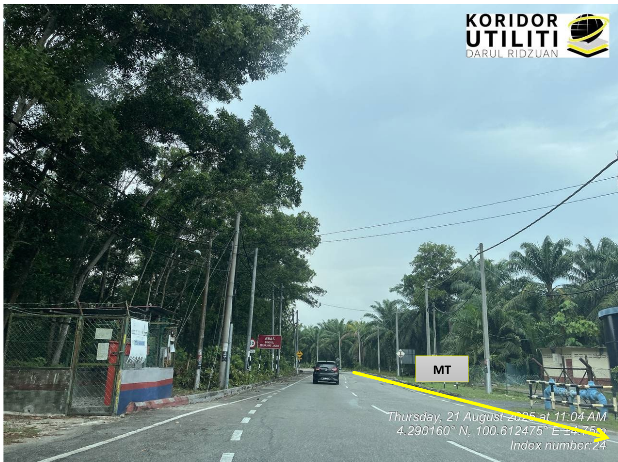
LOKASI KERJA DI JALAN DAMAI LAUT
