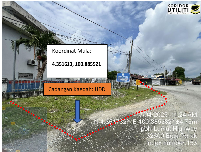
LOKASI KERJA: LEBUHRAYA IPOH – LUMUT (KAEDAH HDD)
