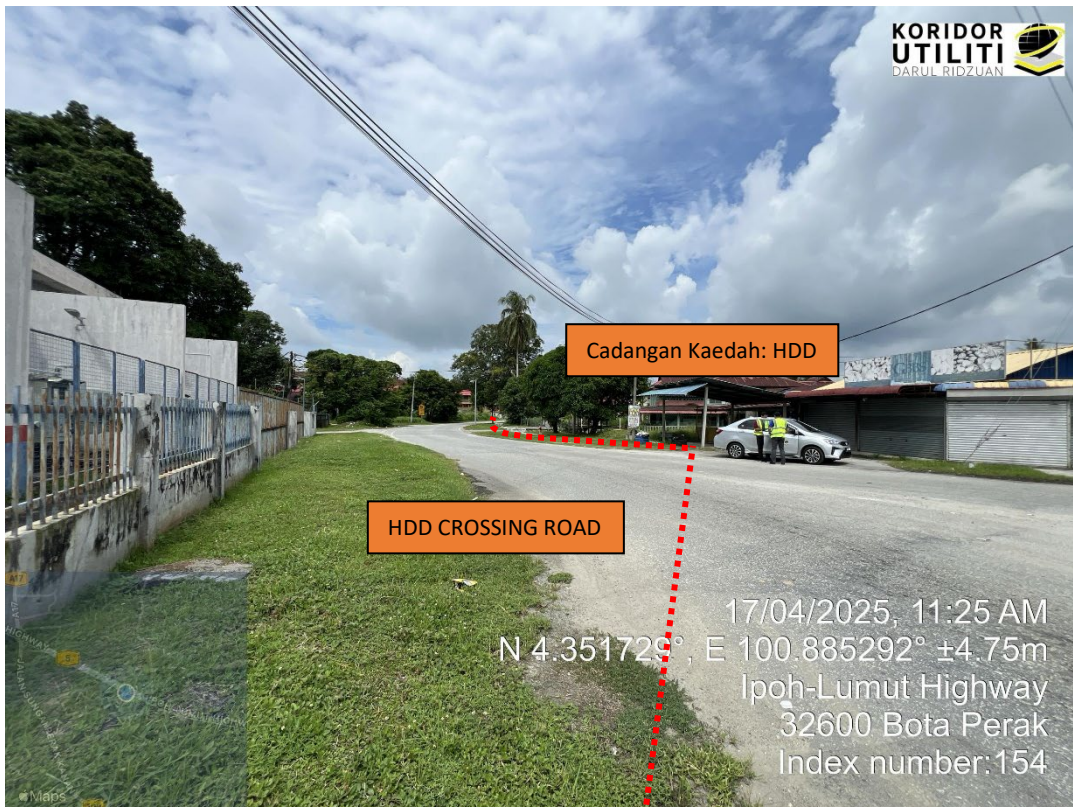
LOKASI KERJA: JALAN LALUAN KE ARAH SEK. MEN. DATO' ABDUL RAHMAN YAKUB (KAEDAH HDD)
