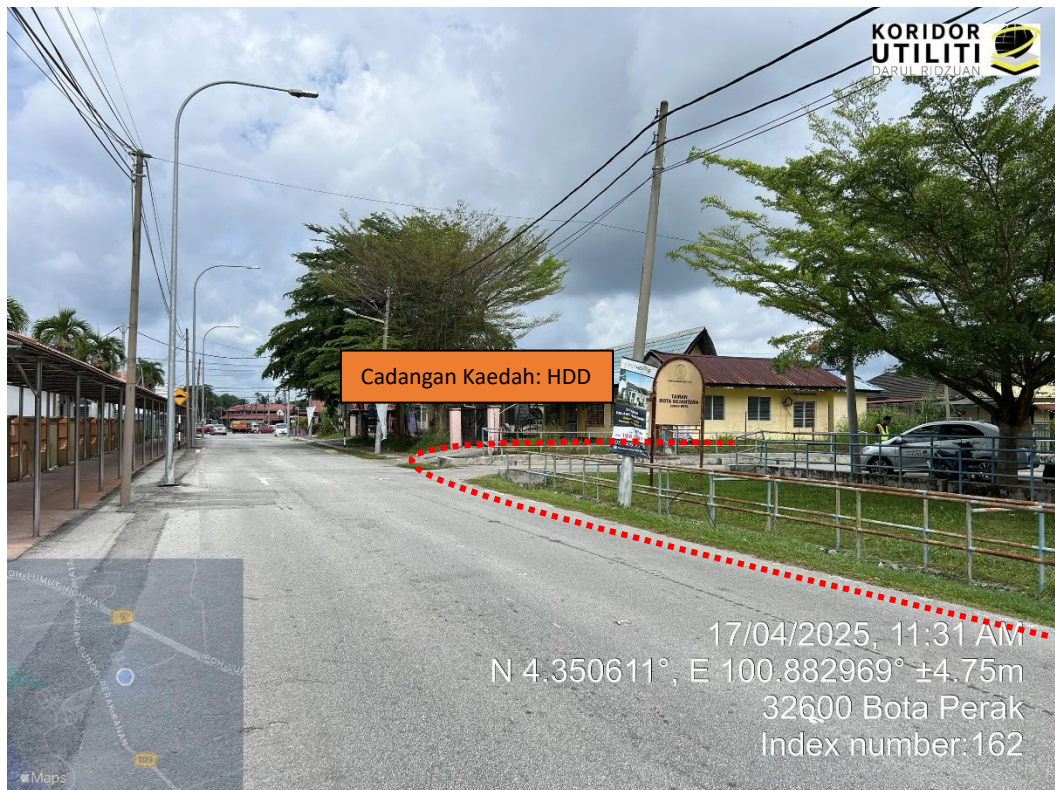
LOKASI KERJA: JALAN MENGHALA KE ARAH JALAN BOTA SEJAHTERA (KAEDAH HDD)
