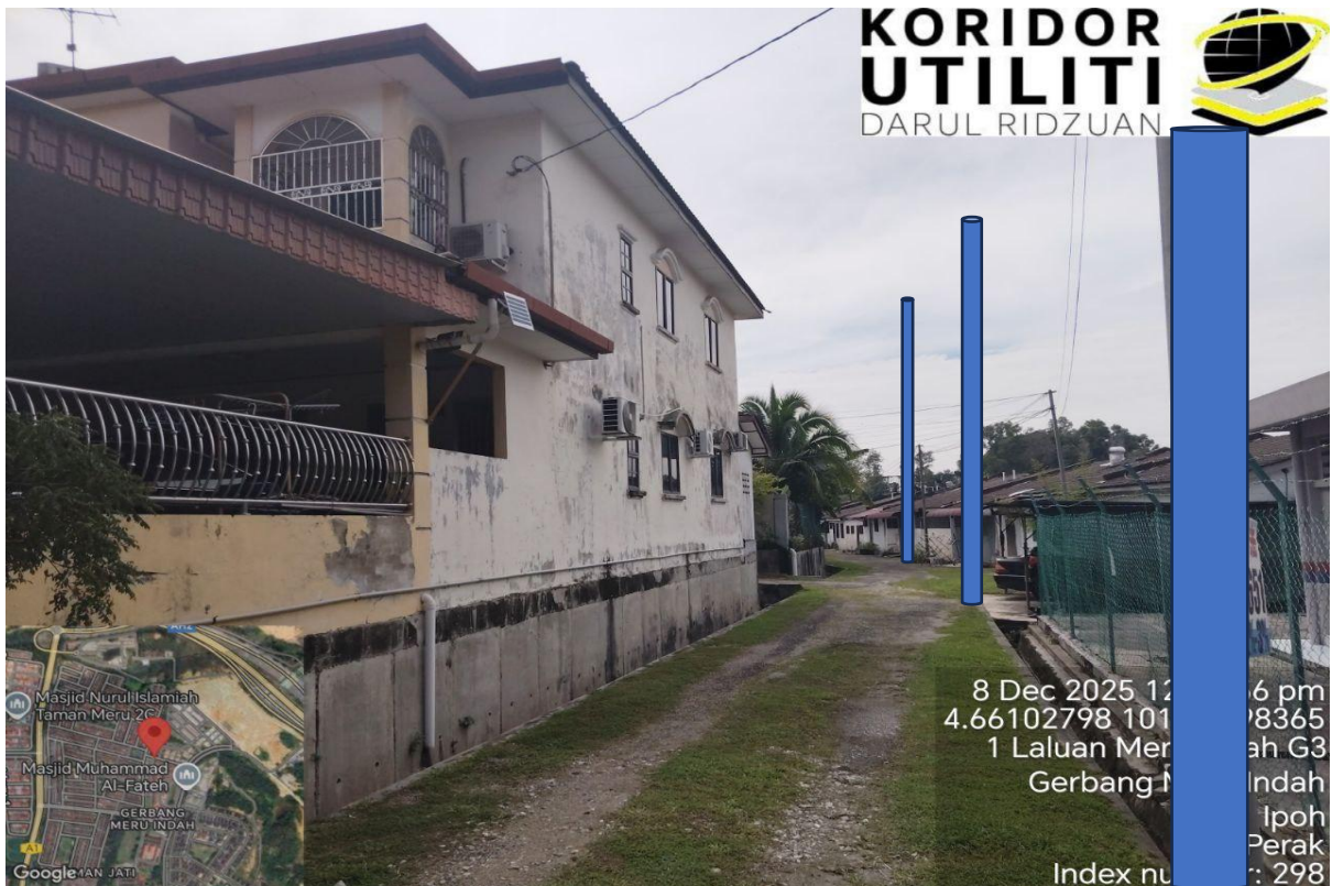
LOKASI KERJA PENANAMAN TIANG DI LALUAN MERU INDAH G3
