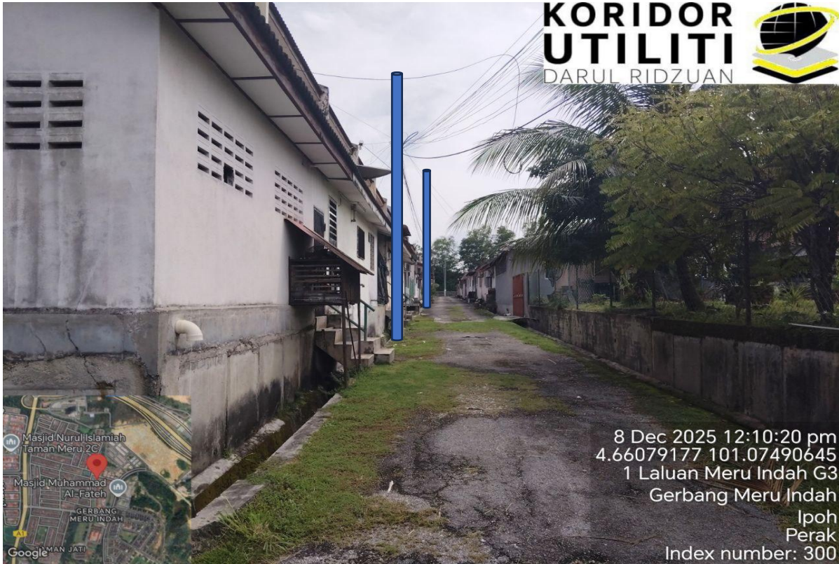
LOKASI KERJA PENANAMAN TIANG DI LALUAN MERU INDAH G3 ( LORONG BELAKANG )
