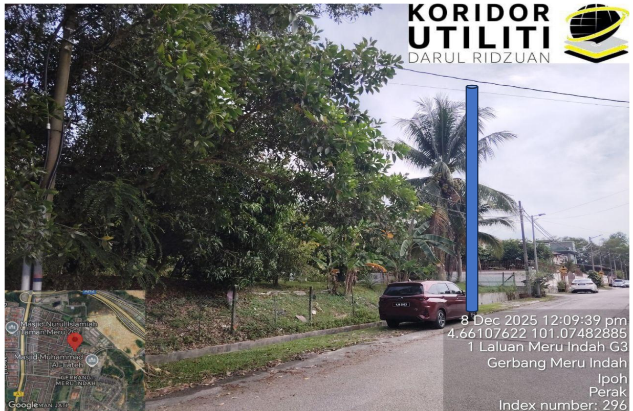
LOKASI KERJA PENANAMAN TIANG DI LALUAN MERU INDAH G3
