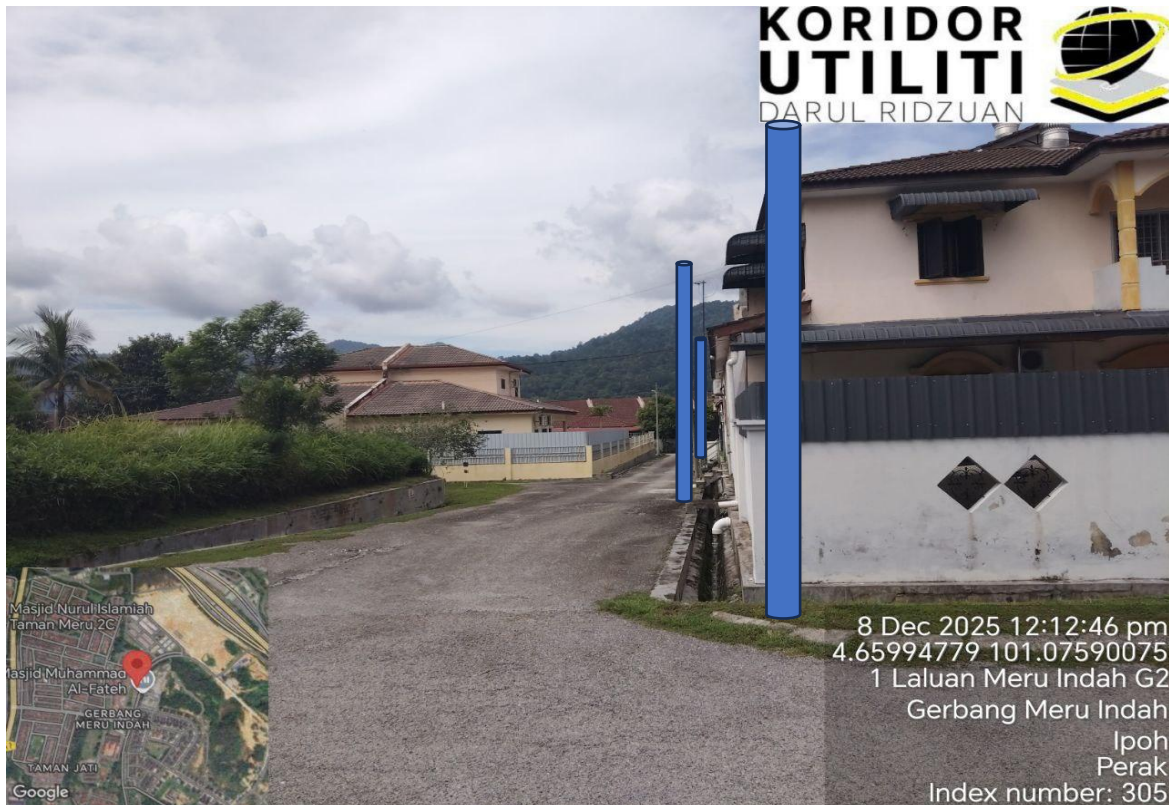
LOKASI KERJA PENANAMAN TIANG DI LALUAN MERU INDAH G2 ( LORONG BELAKANG )
