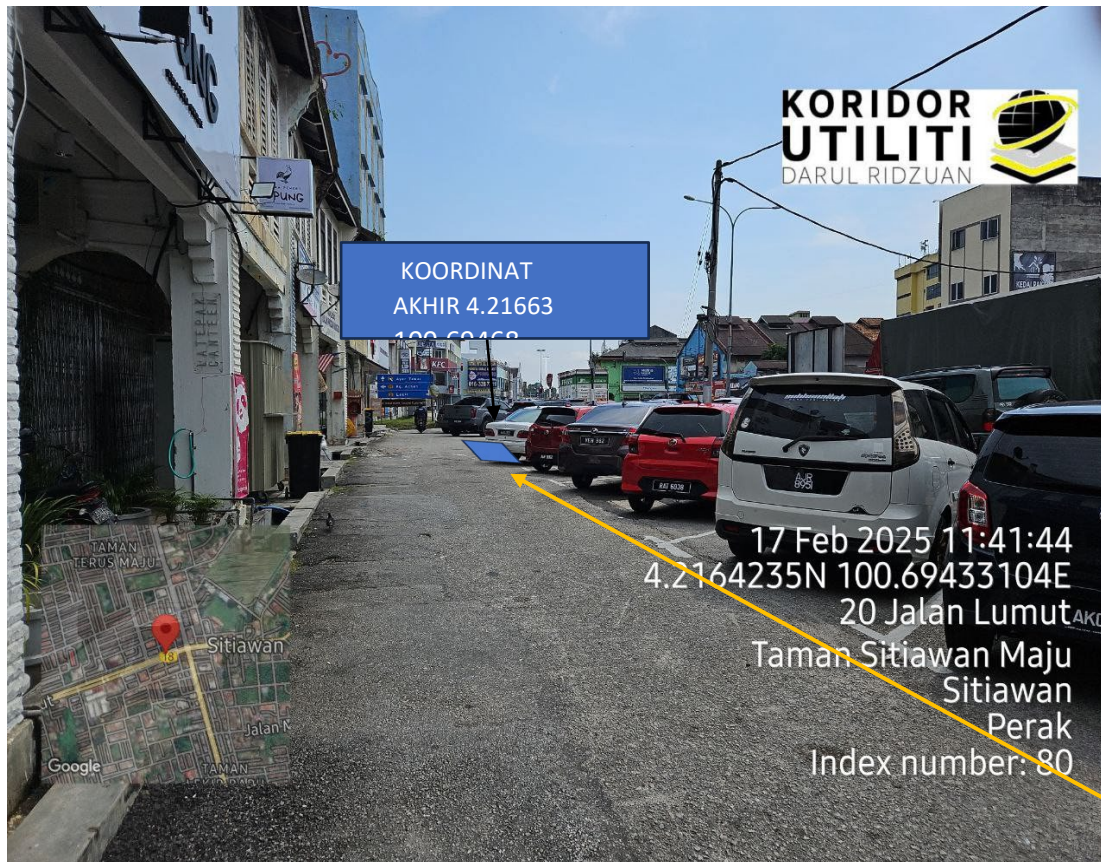
KOREKAN MELALUI SEBELAH KANAN - EXISTING MANHOLE
