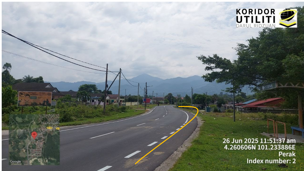
JAJARAN CADANGAN PEMASANGAN TIANG
