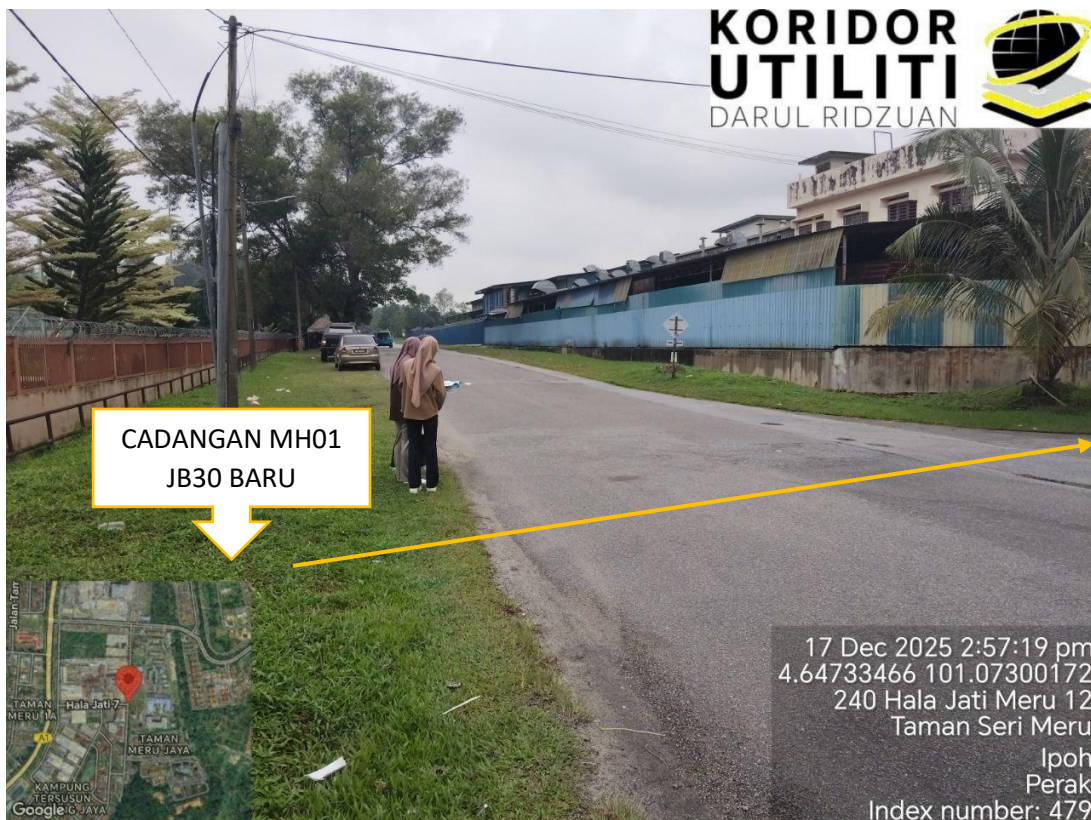
KAEDAH HDD KE HALA JATI 7
