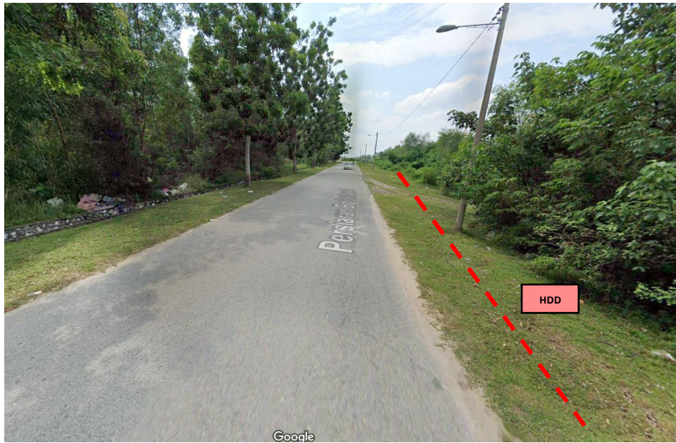
JAJARAN KERJA HDD DI PERSIARAN BG PERDANA 10 (JALAN MILIK MDBG)
