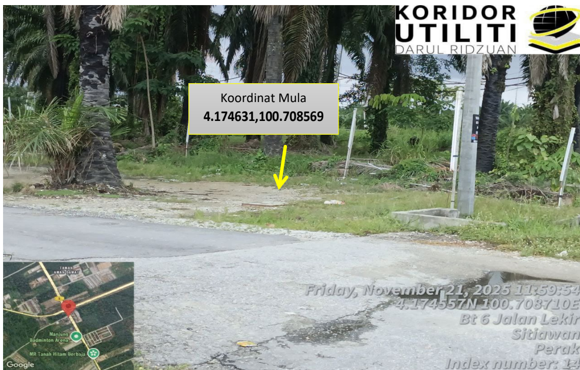
LOKASI KERJA DI JALAN SG WANGI – KG KAYAN (FT005) (KOORDINAT MULA)
