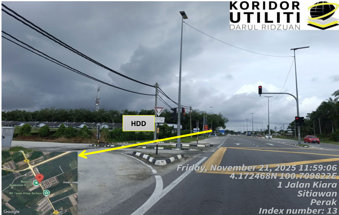
LOKASI KERJA DI JALAN SG WANGI – KG KAYAN (FT005)
