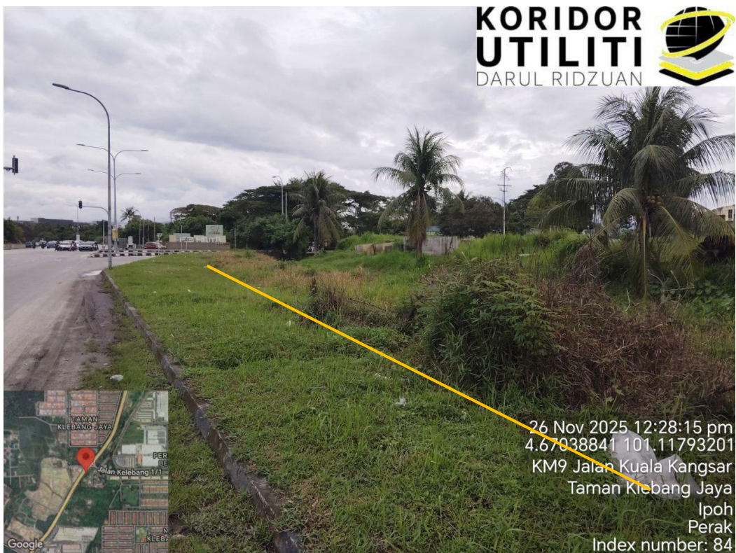
KOREKAN TERBUKA DI BAHU JALAN (GREEN AREA) - JALAN KUALA KANGSAR
