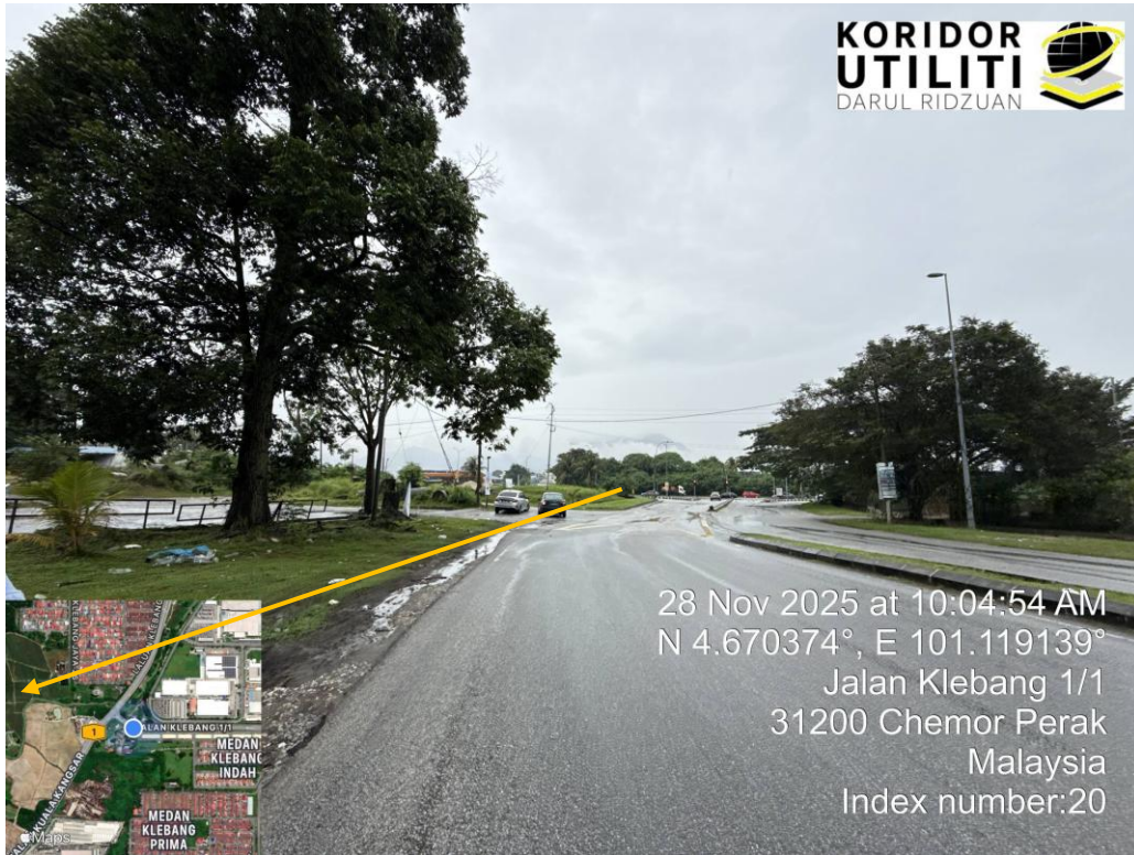
JAJARAN PEMASANGAN UTILITI – OPEN CUT
