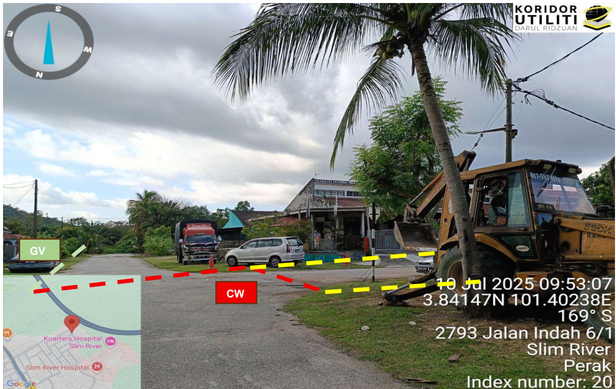
Rajah 4: Crossing Jalan Indah 6/1 dan Jalan Indah 6/2
