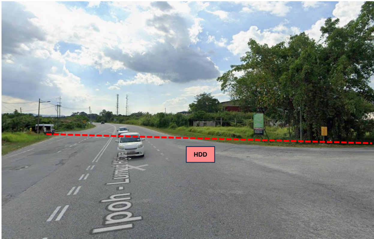
LOKASI KERJA-KERJA KOREKAN HDD CROSSING DI JALAN LAHAT - PUSING KE IPOH-LUMUT HIGHWAY (FT5)
