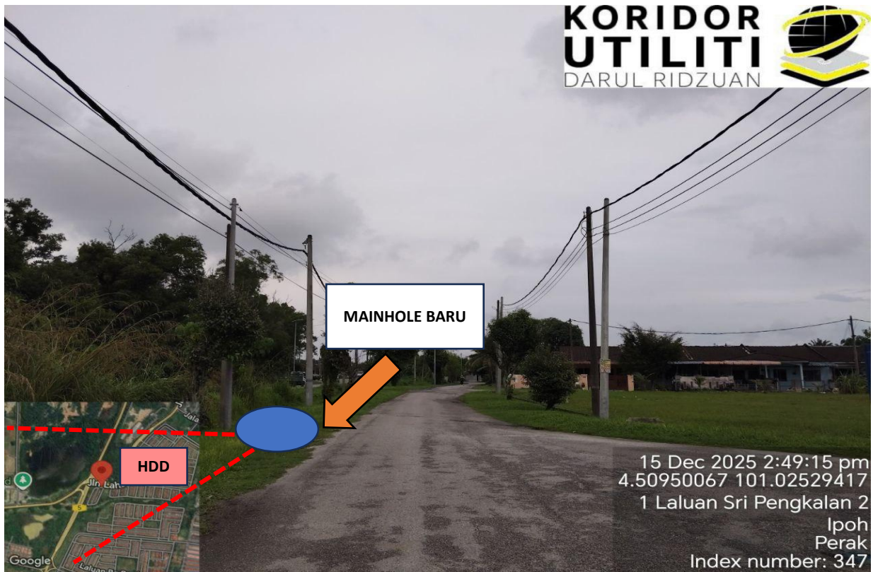
LOKASI AKHIR KERJA-KERJA KOREKAN HDD DI LALUAN SRI PENGKALAN 2
