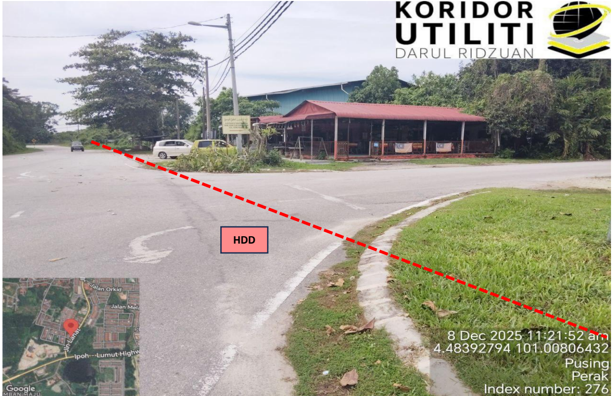
LOKASI KERJA-KERJA KOREKAN HDD DI JALAN JALAN LAHAT - PUSING
