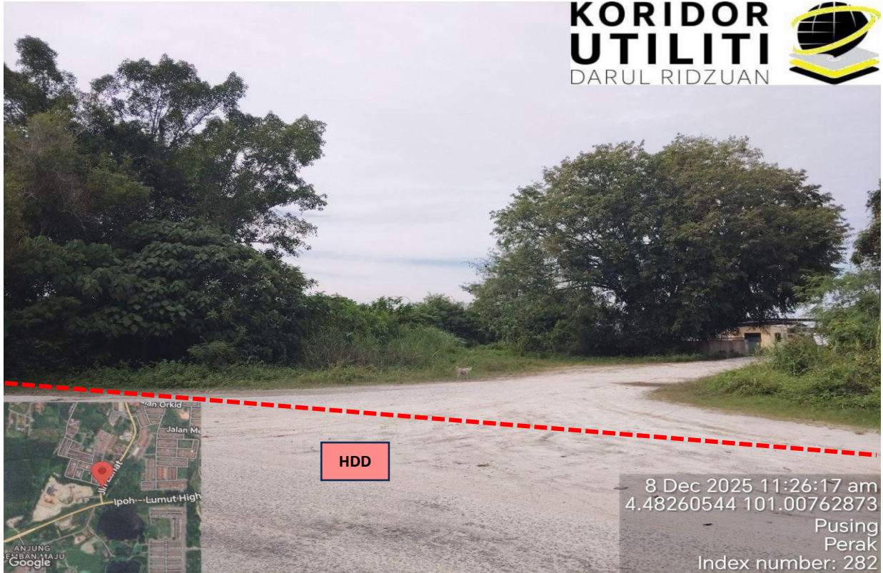
LOKASI KERJA-KERJA KOREKAN HDD DI JALAN LAHAT - PUSING
