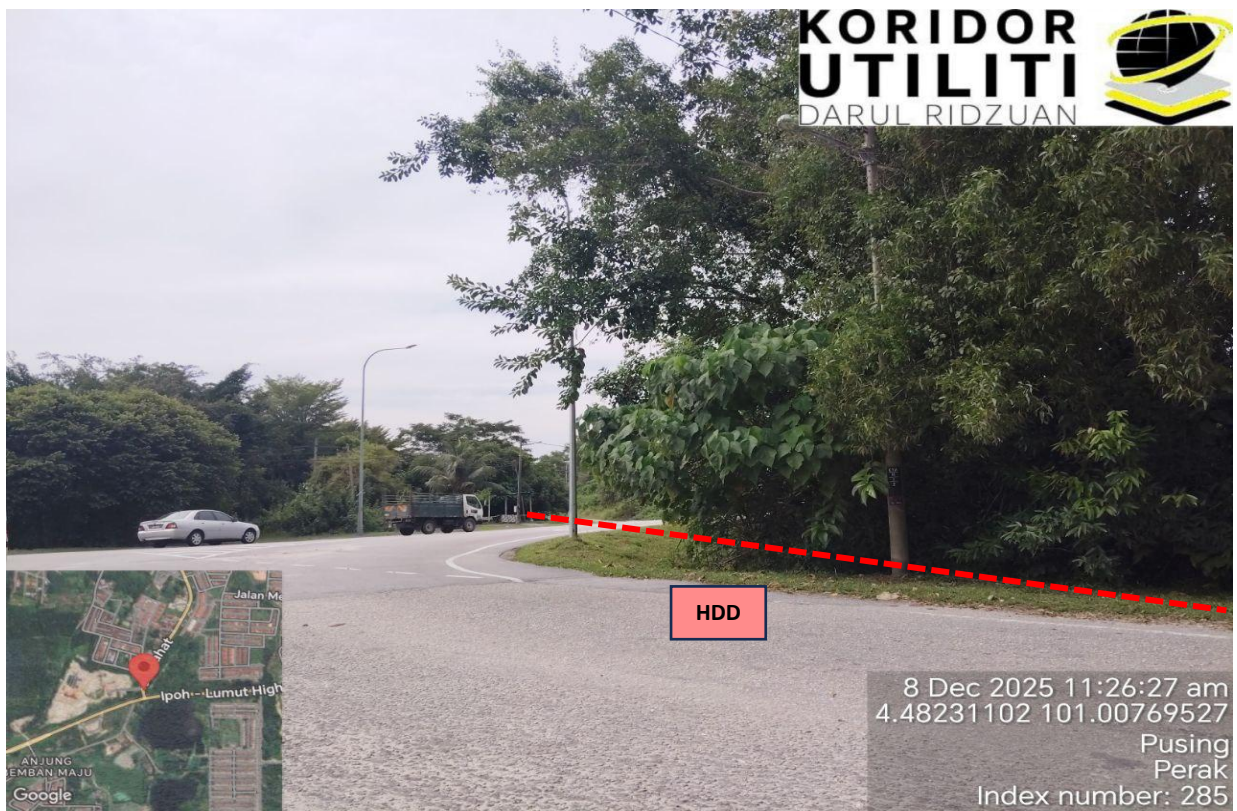
LOKASI KERJA-KERJA KOREKAN HDD DI JALAN LAHAT - PUSING
