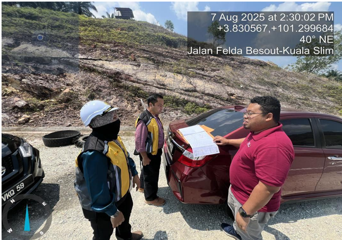
Rajah 5: Perbincangan bersama Pemohon dan Penyedia Utiliti berkenaan jajaran dan kaedah korekan
