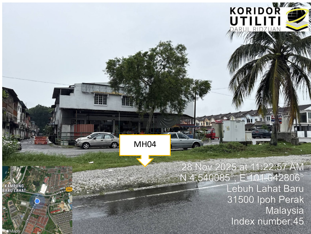
LOKASI CADANGAN MANHOLE
