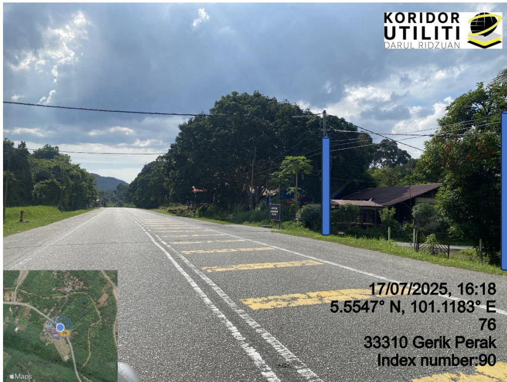
LOKASI DI JALAN JALAN BALING – KUALA KANGSAR
