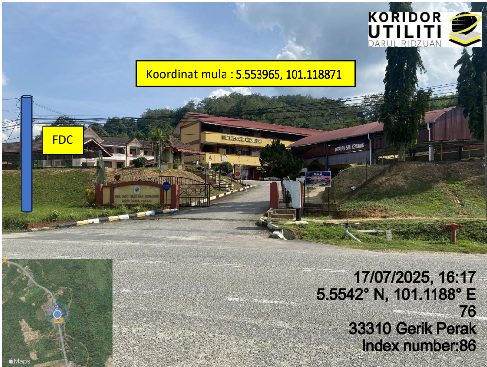
LOKASI DI JALAN SMK DATO SERI WAN MOHAMED
