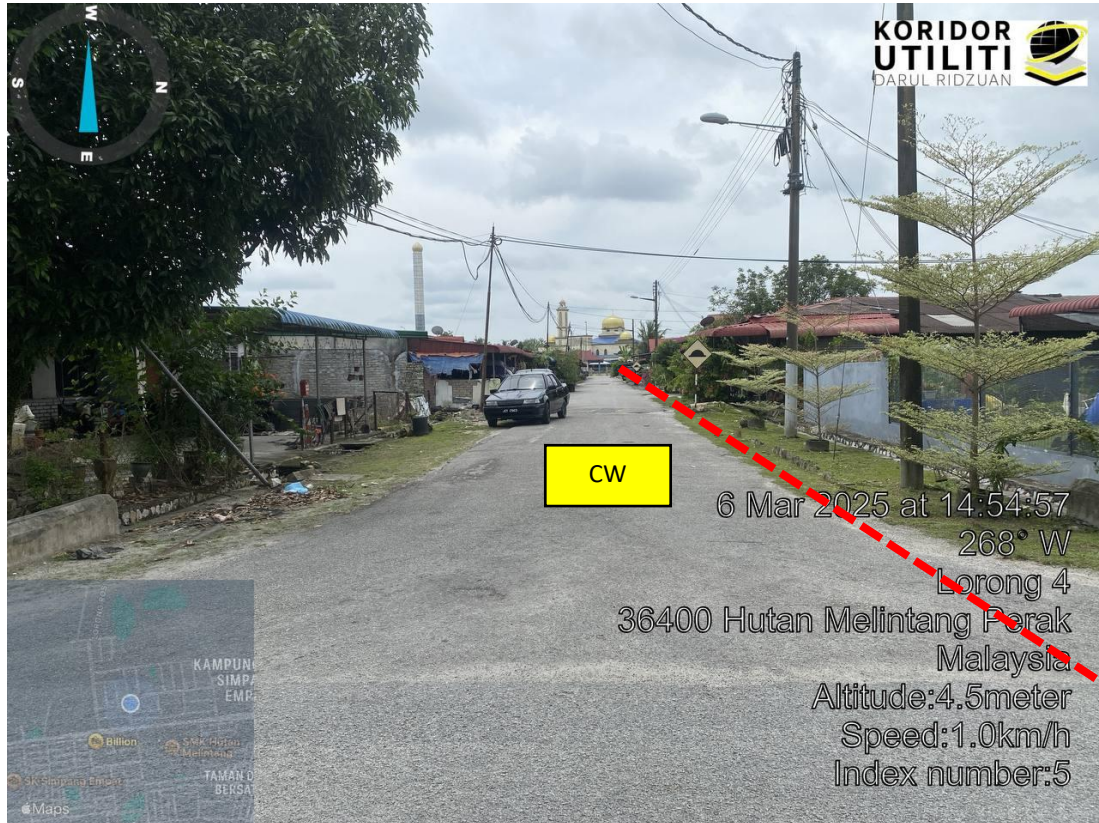
LOKASI DI RUMAH AWAM LORONG 4
