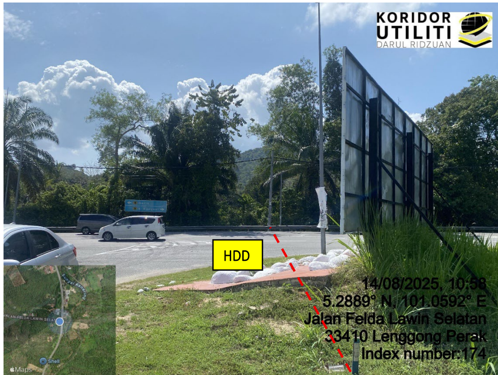
LOKASI DI JALAN BALING – KUALA KANGSAR
