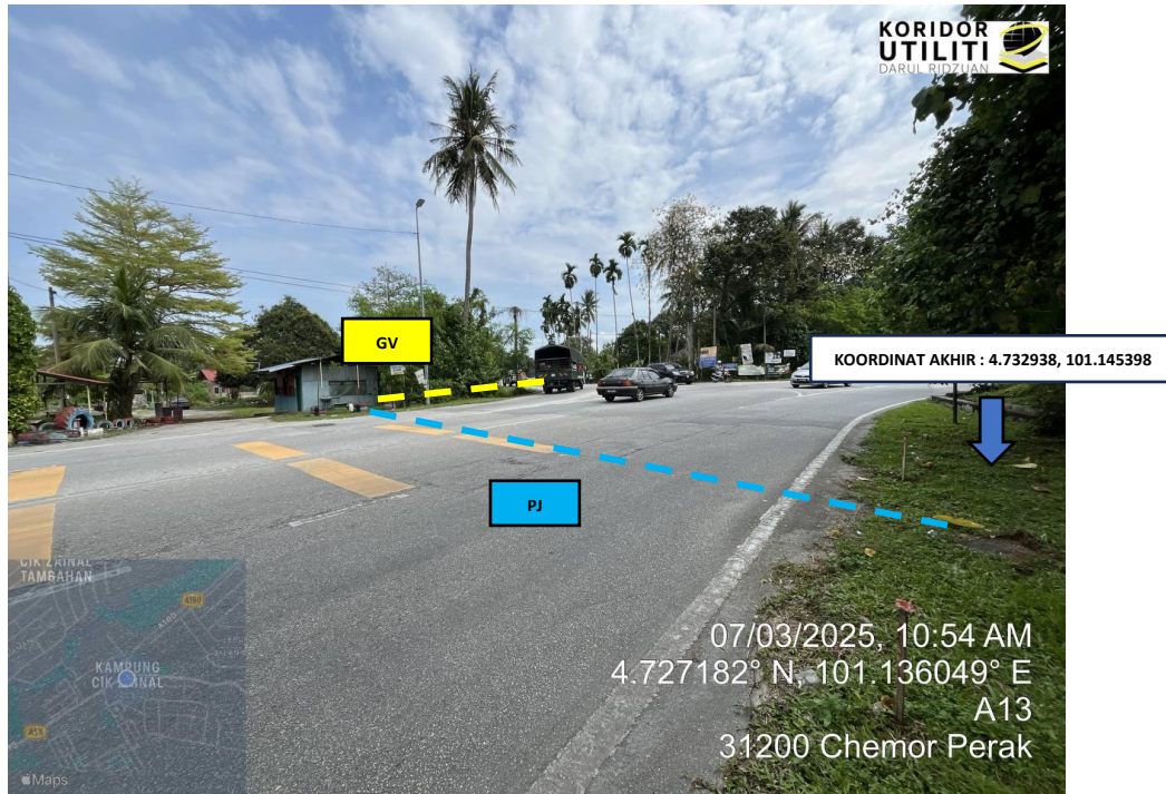
LOKASI KOORDINAT AKHIR KOREKAN TERBUKA JALAN TIDAK BERTURAP DAN PIPE JACKING (CROSSING) DI JALAN CHEMOR – ULU KUANG (A160)
