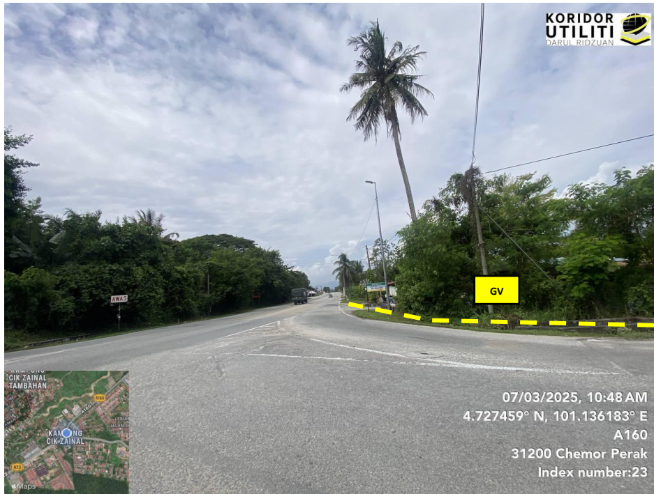
JAJARAN KOREKAN TERBUKA JALAN TIDAK BERTURAP DI JALAN CHEMOR – ULU KUANG (A160)
