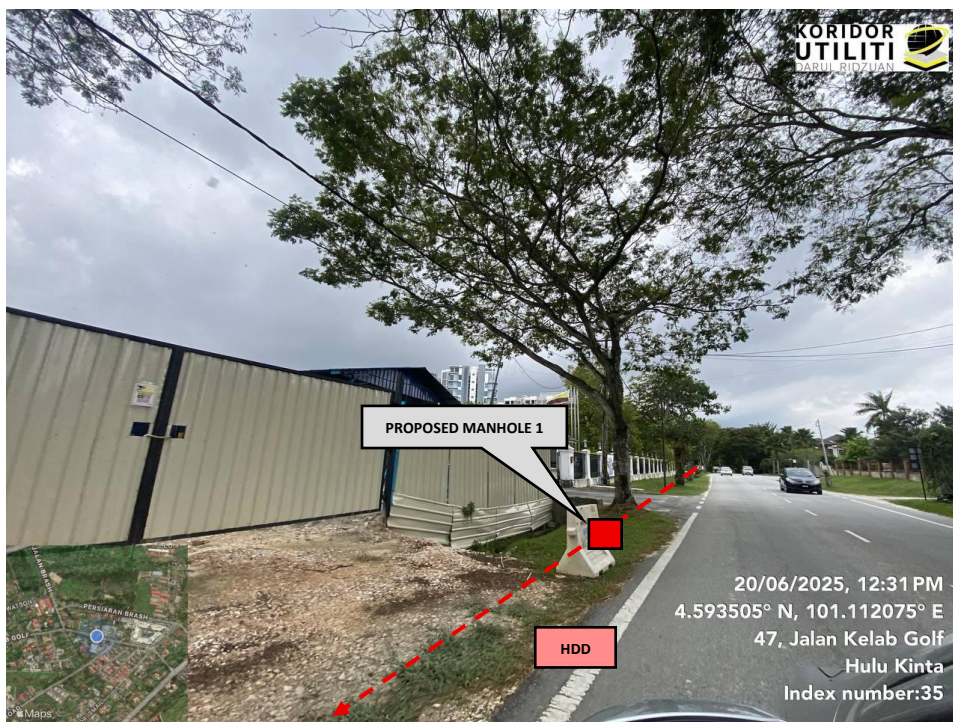
JAJARAN KERJA HDD DI JALAN KELAB GOLF
