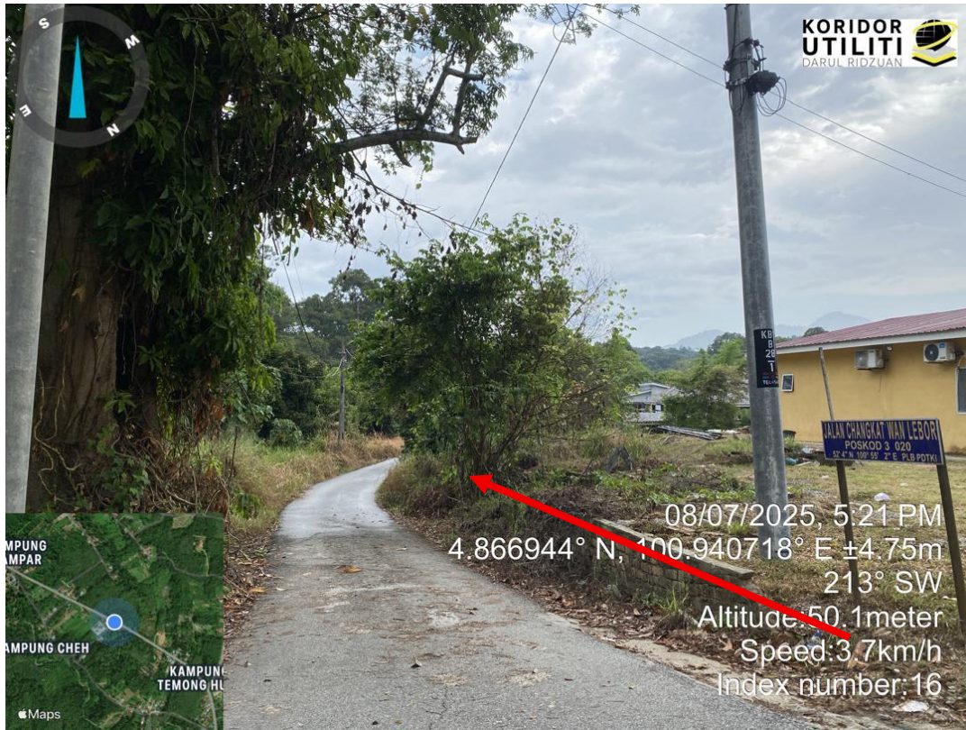
CADANGAN PENANAMAN TIANG DI JALAN CHANGKAT WAN LEBOR (PDT)
