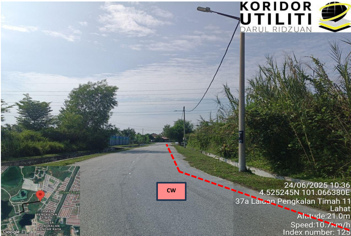
LOKASI KERJA KOREKAN TERBUKA DI PENGKALAN PERMAI 15
