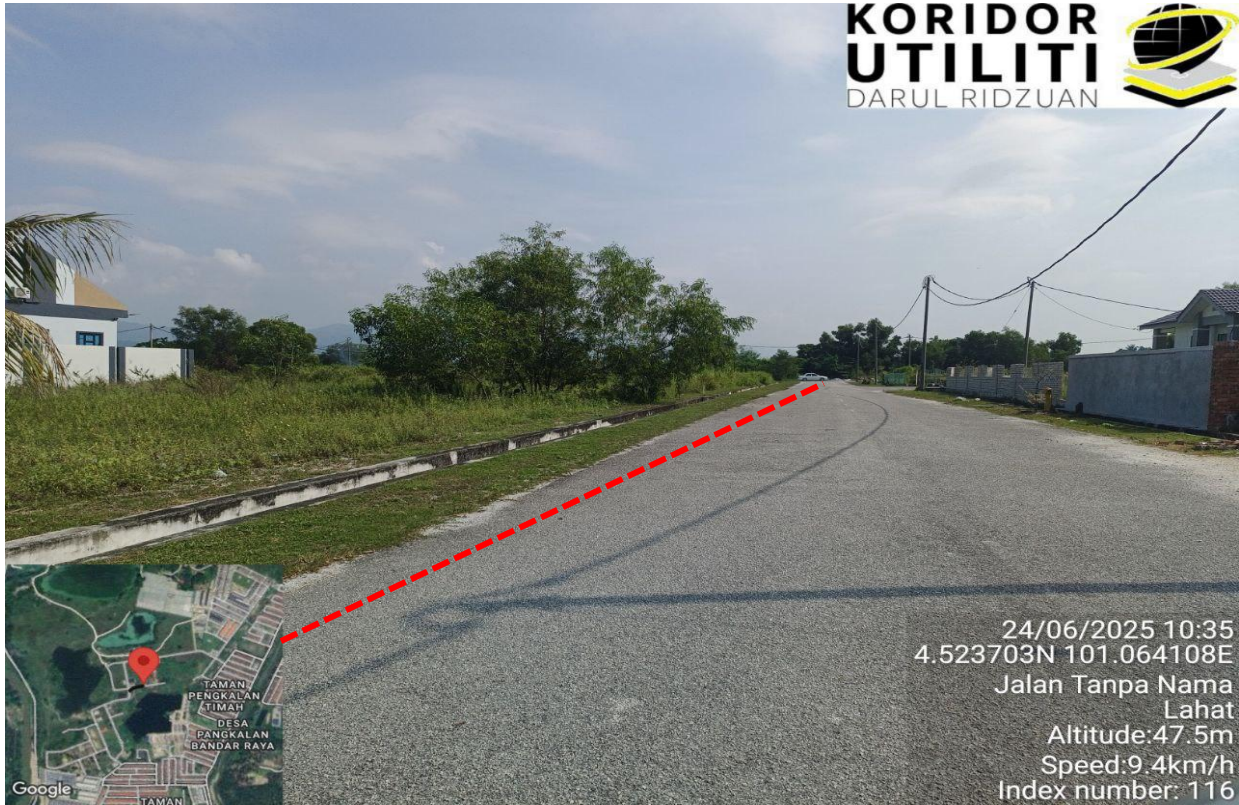
LOKASI KERJA KOREKAN TERBUKA DI PENKALAN PERMAI 17
