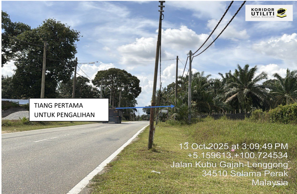
PENGALIHAN TIANG DARI JALAN JKR KE JALAN RIZAB PERSENDIRIAN
