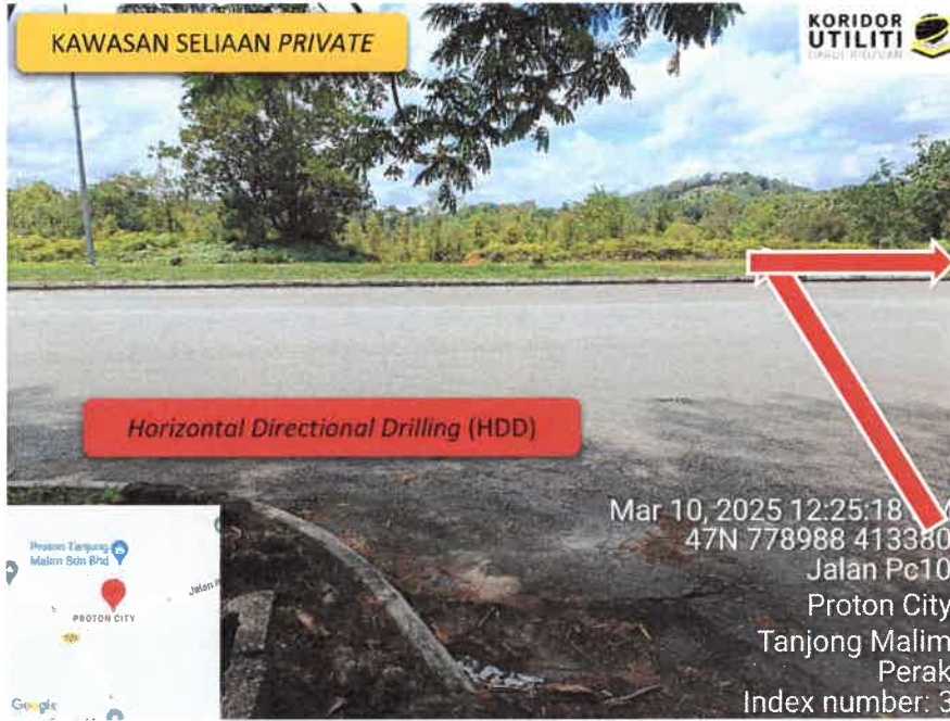
KAEDAH HDD DI JALAN PC10
