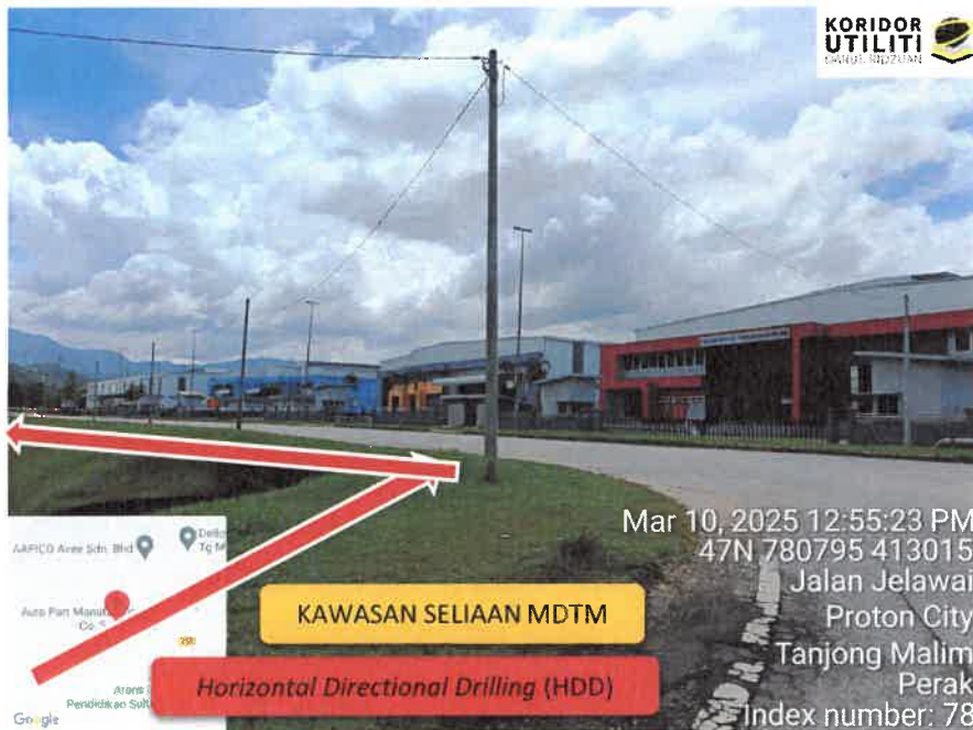
KAEDAH HDD DI JALAN JELAWAI 2
