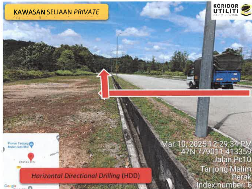
KAEDAH HDD DI JALAN PC10
