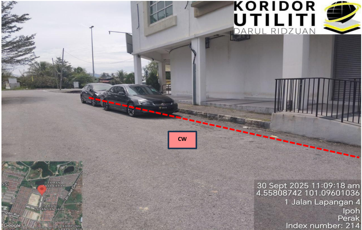
LOKASI KERJA-KERJA KOREKAN TERBUKA DI JALAN LAPANGAN 4
