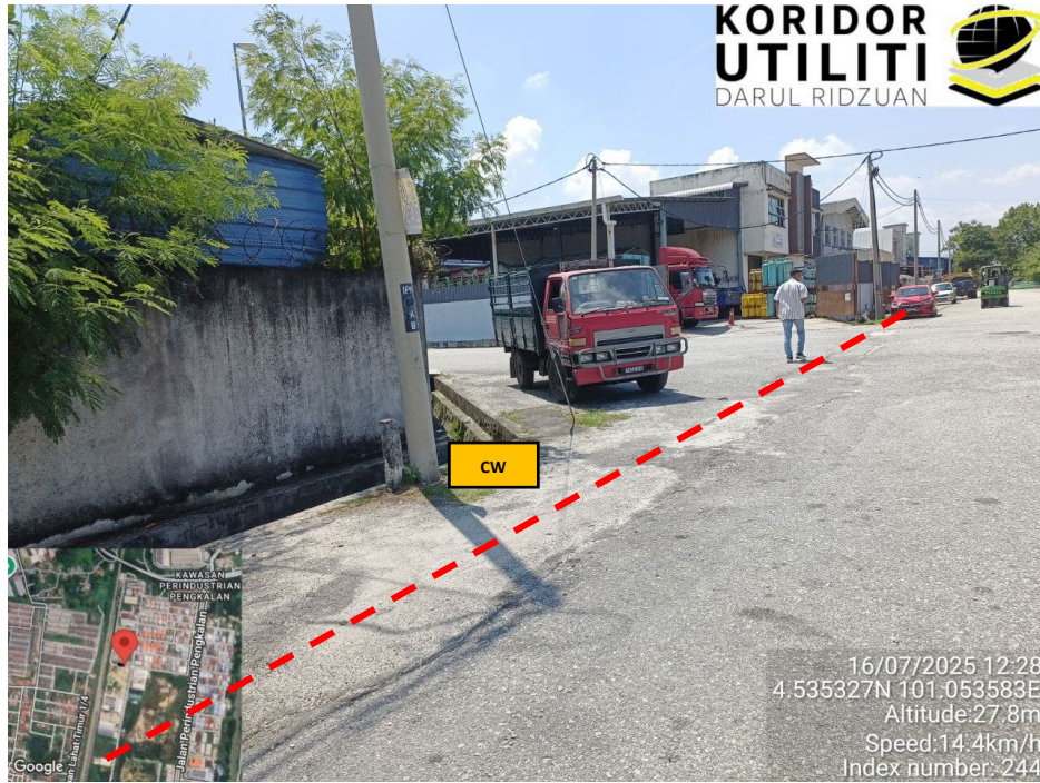
JAJARAN KOREKAN TEERBUKA DI PERSIARAN PERINDUSTRI PENGKALAN 14
