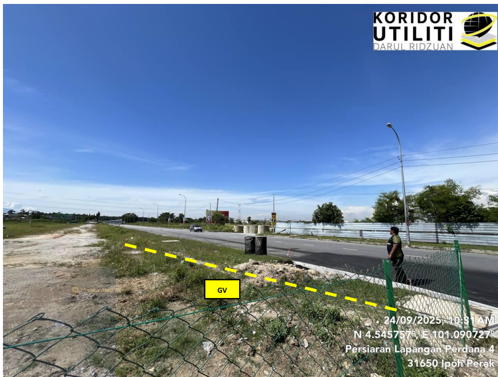
JAJARAN KOREKAN TERBUKA DI PERSIARAN LAPANGAN PERDANA 4
