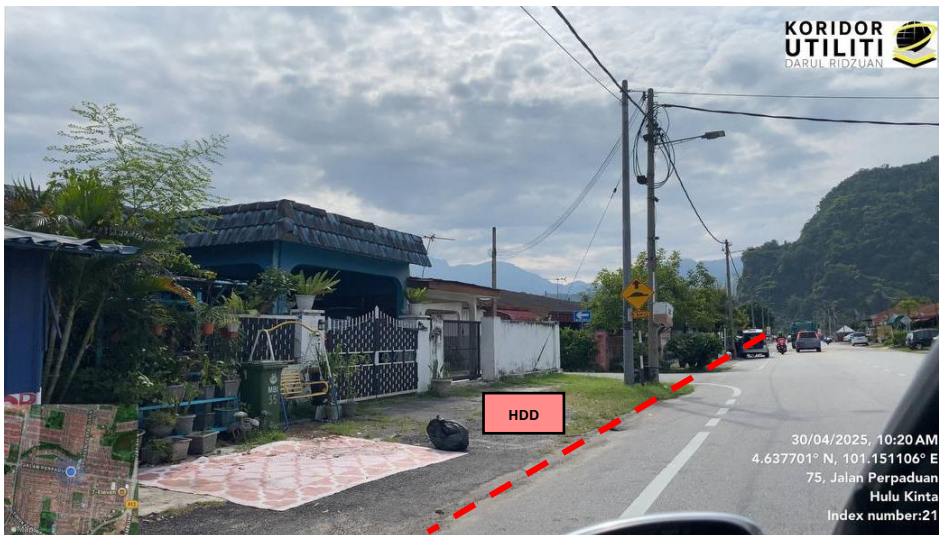
JAJARAN KERJA HDD DI JALAN PERPADUAN
