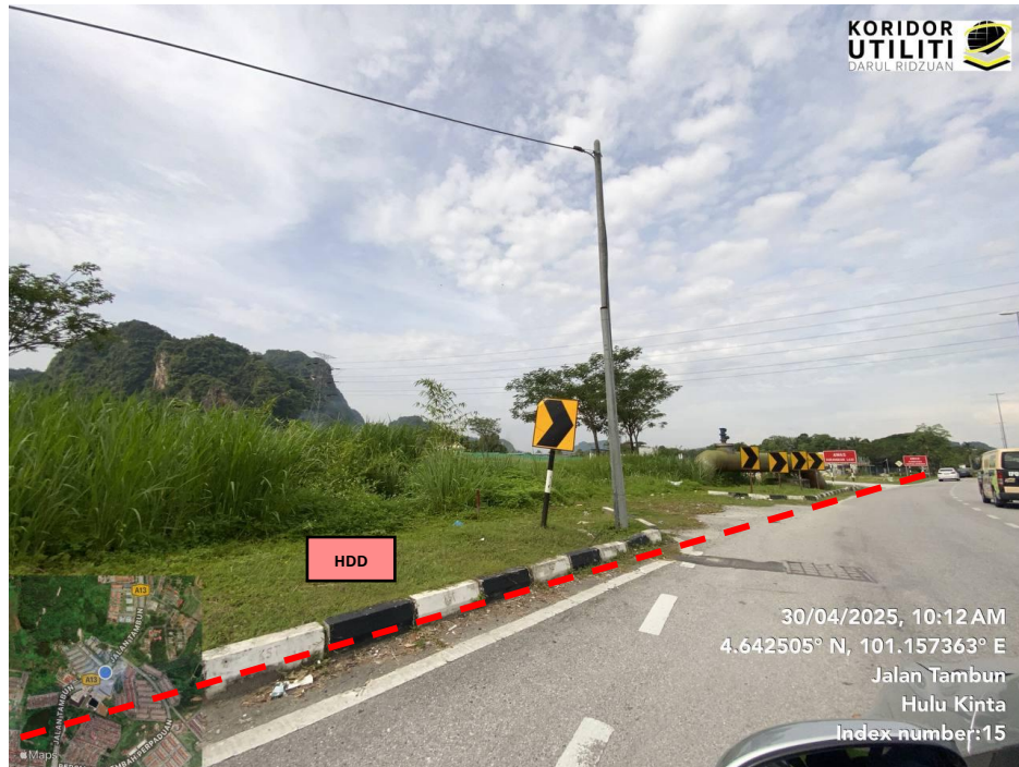
JAJARAN KERJA HDD DI JALAN IPOH – TAMBUN (A013)
