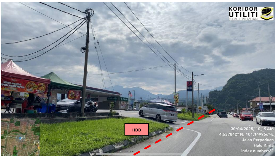
JAJARAN KERJA HDD DI JALAN PERPADUAN
