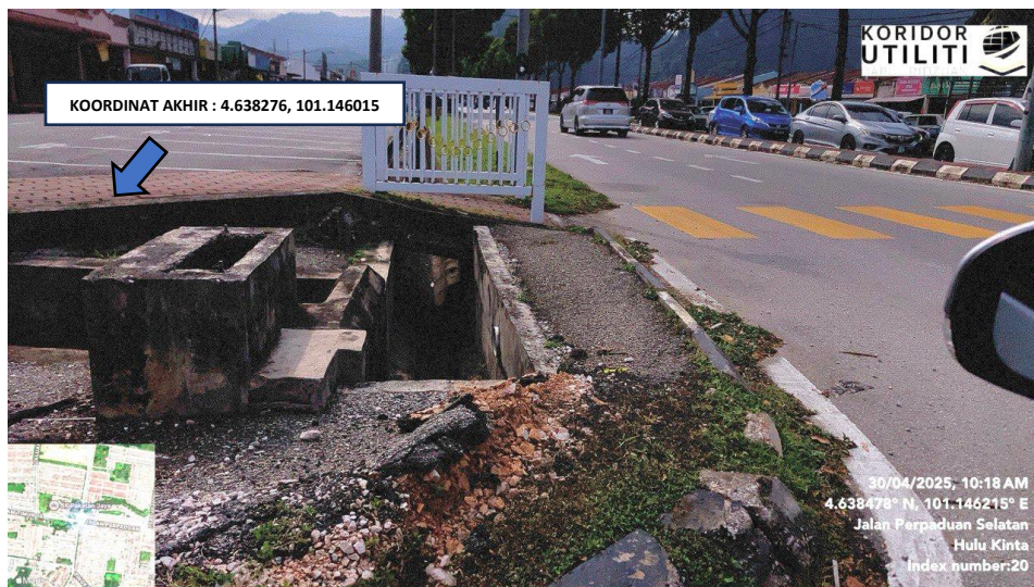
KOORDINAT AKHIR KERJA HDD DI JALAN PERPADUAN SELATAN
