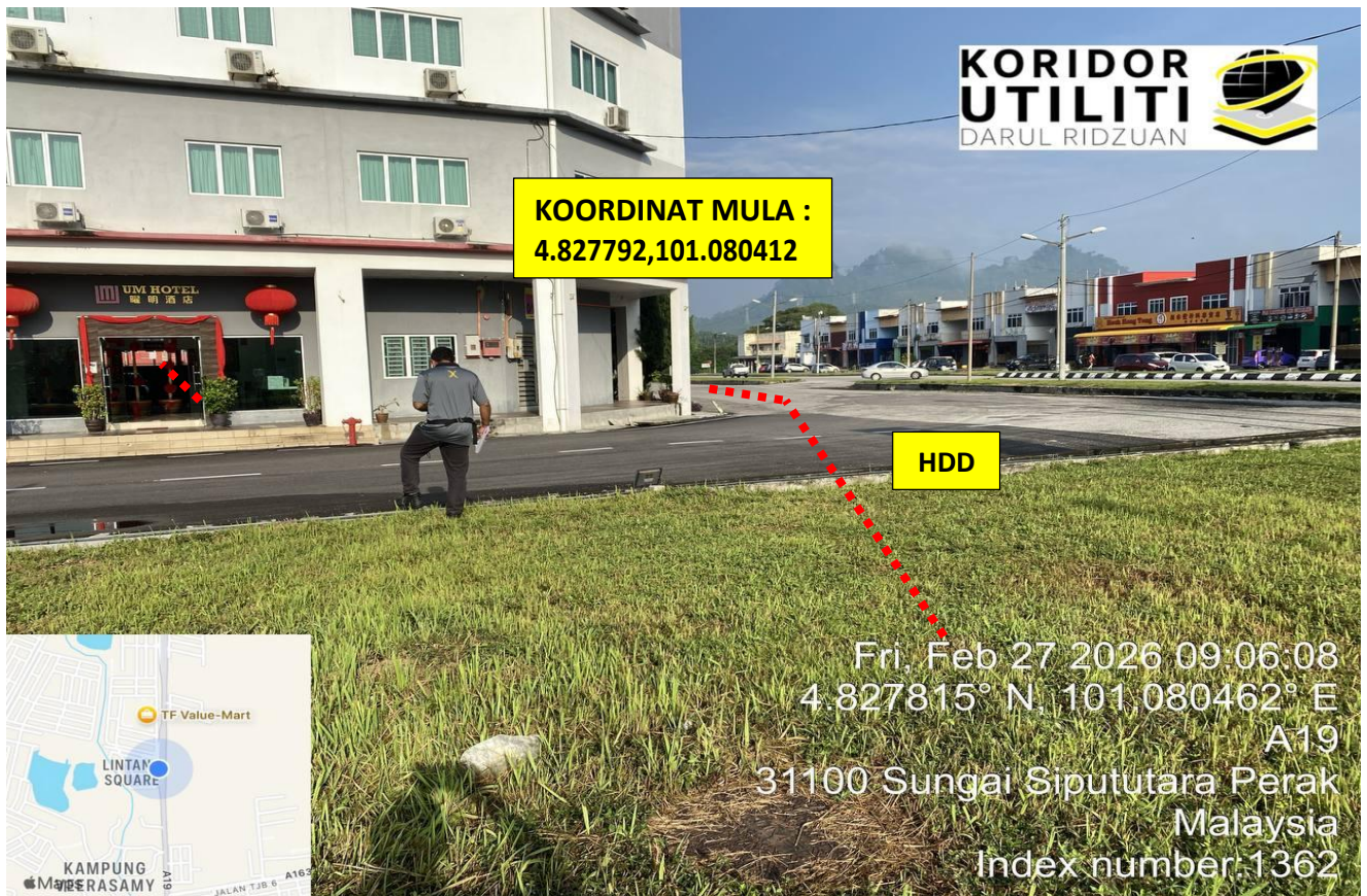
LOKASI DI EXISTING MANHOLE
