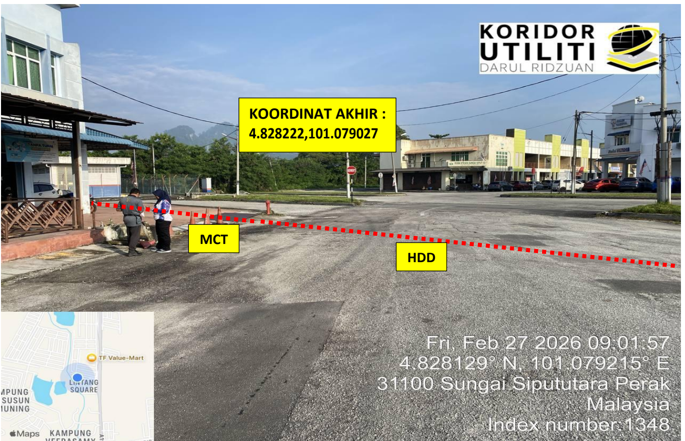
LOKASI DI CADANGAN MANHOLE BAHARU
