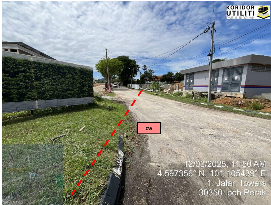
JAJARAN KERJA KOREKAN TERBUKA DI JALAN TOWER
