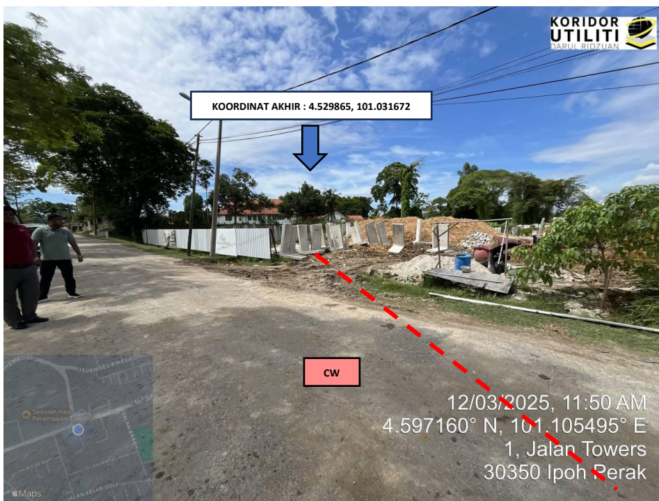
LOKASI AKHIR KERJA KOREKAN TERBUKA DI JALAN TOWER
