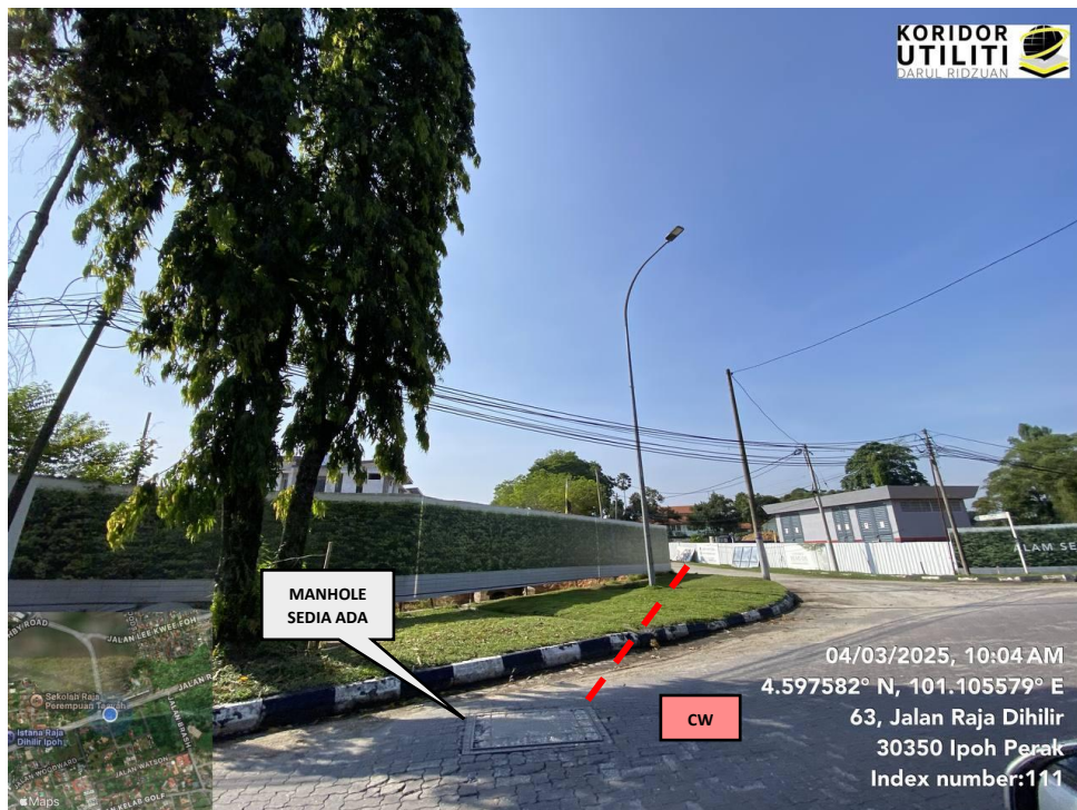
LOKASI KOORDINAT MULA KERJA KOREKAN TERBUKA DI JALAN TOWER (Sambungan kepada manhole komunikasi sedia ada)
