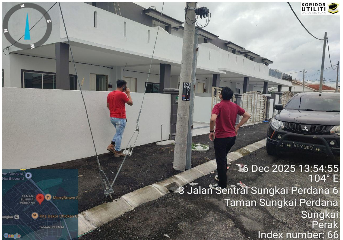
Rajah 6: Perbincangan bersama Pemohon dan Penyedia Utiliti berkenaan jajaran dan kaedah korekan
