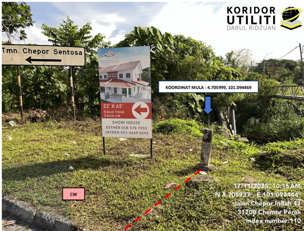
LOKASI KOORDINAT MULA KOREKAN TERBUKA DI JALAN CHEPOR INDAH 41
