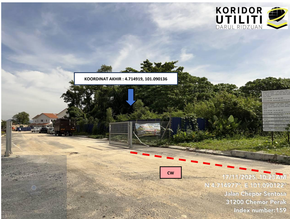
LOKASI KOORDINAT AKHIR KOREKAN TERBUKA DI JALAN CHEPOR SENTOSA
