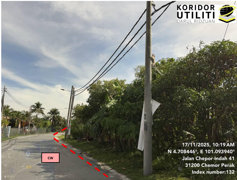
AJARAN KOREKAN TERBUKA DI JALAN CHEPOR INDAH 41
