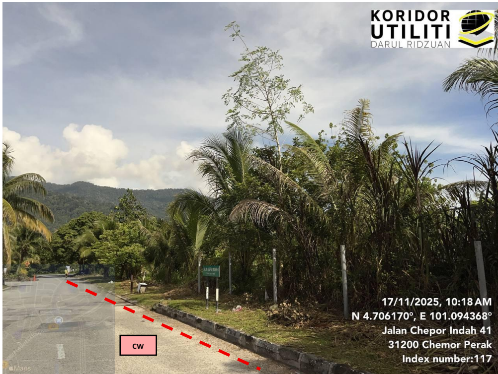
JAJARAN KOREKAN TERBUKA DI JALAN CHEPOR INDAH 41
