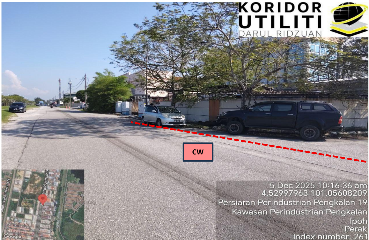
LOKASI KERJA KOREKAN TERBUKA DI JALAN KILANG PENGKALAN 2A
